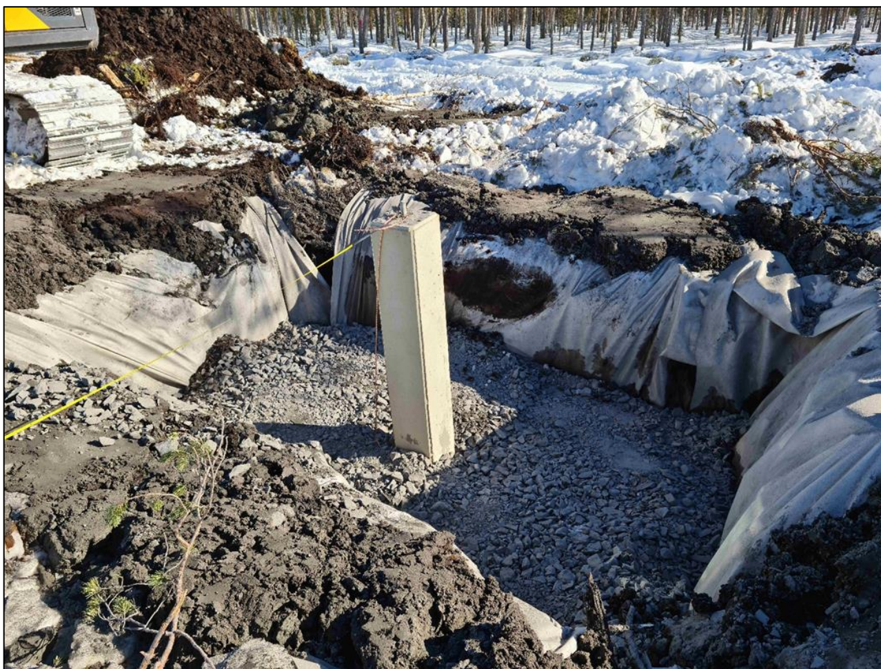
Kuva 3.5. Pylvään perustuselementin asentaminen.
