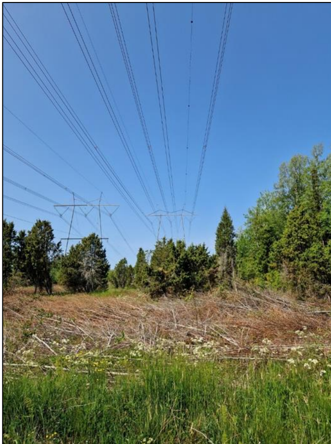
Kuva 3.9. Esimerkki valikoivasta raivauksesta.
