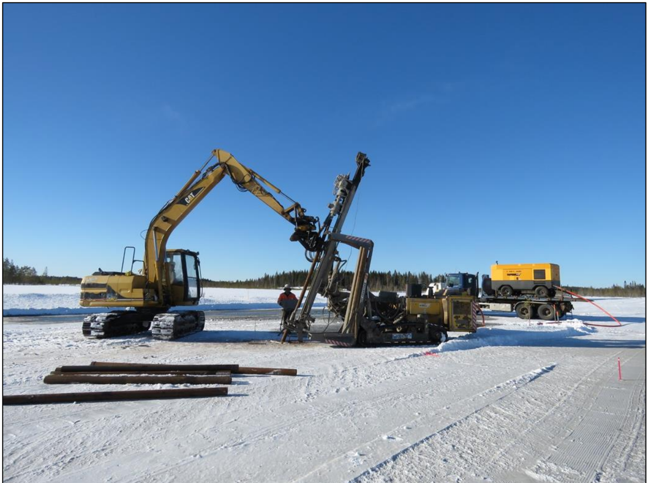
Kuva 3.7. Porapaaluperustuksen tekoa suoalueella, jossa työalue on jäädytetty.
