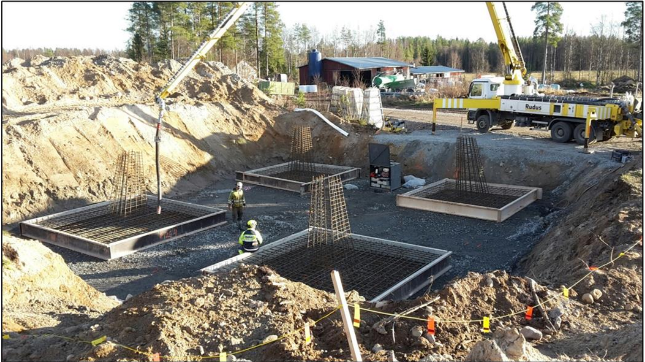
Kuva 3.6. Vapaasti seisovan pylvään perustuksen pohjatöitä.
