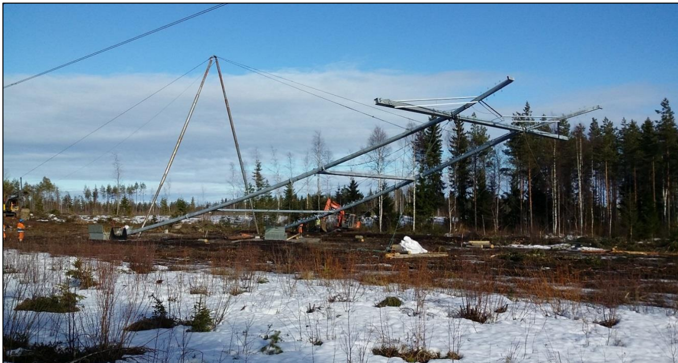
Kuva 3.8. Voimajohtopylvään pystytys.
