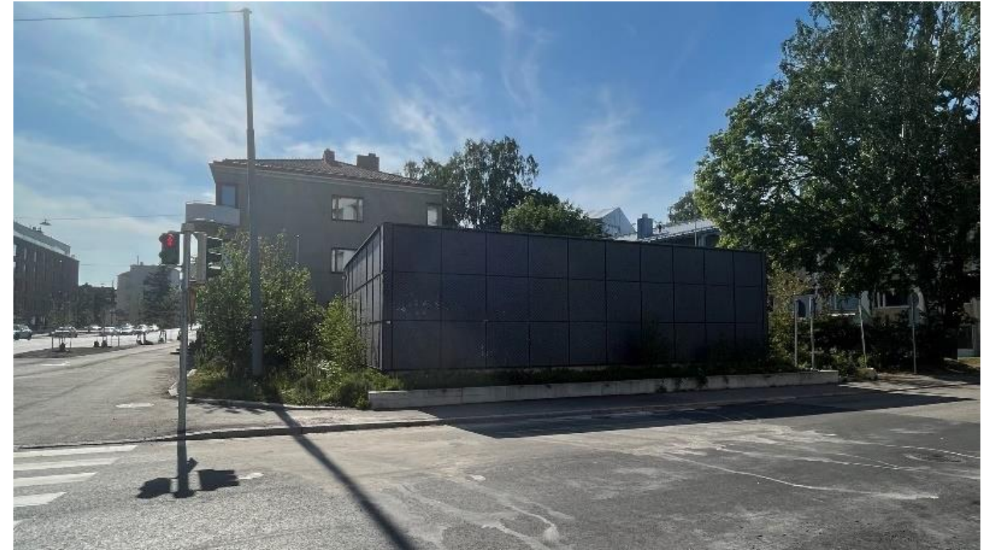
Kuva 2.4 Esimerkki Lauttasaaressa sijaitsevasta Länsimetron kuilurakennuksesta, jossa ratatunnelia palvelevaa tekniikkaa on viety mahdollisimman paljon maan alle. Maanpäällisen rakennuksen pituus on noin 16 metriä, leveys noin 12 metriä ja korkeus noin 4 metriä. (Kuva: Sitowise Oy)
