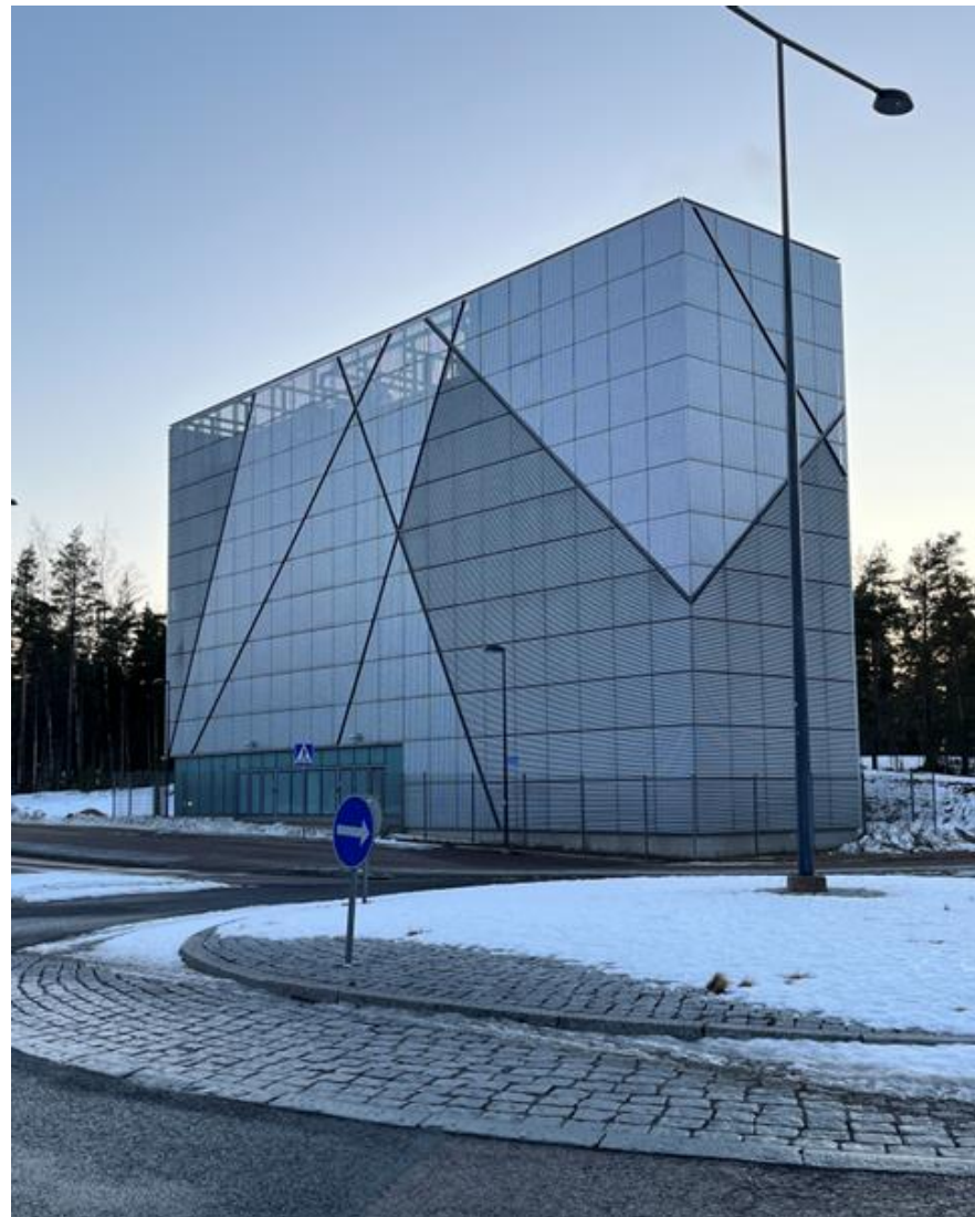
Kuva 2.5 Vantaan Aviapoliksessa sijaitseva Kehäradan tekninen kuilurakennus, jossa ratatunnelia palvelevaa tekniikkaa on sijoitettu maanpäälliseen rakennukseen. Maanpäällisen rakennuksen pituus on noin 33 metriä, leveys noin 8 metriä ja korkeus noin 18 metriä. (Kuva: Sitowise Oy)
