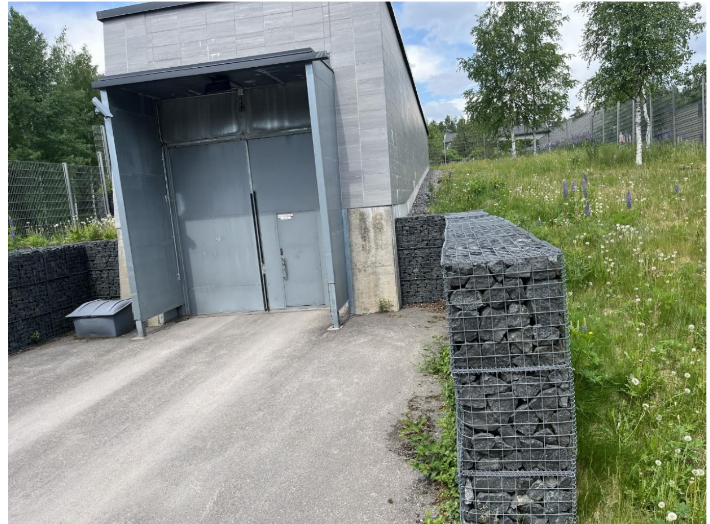
Kuva 2.6 Ajotunnelin suuaukon kattava rakennus (Kuva: Sitowise Oy).
