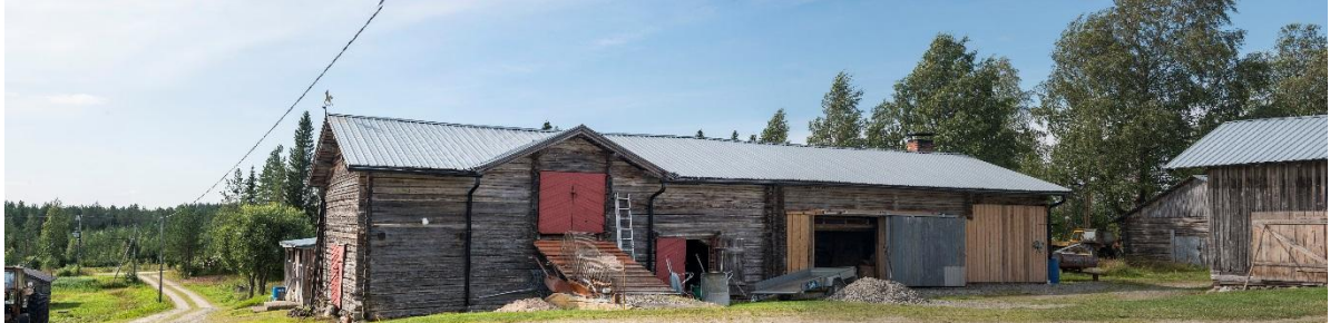
Kuva 14-5. Näkymä Kallion pihapiiristä kohti länttä ja kaivosaluetta. Pihapiiri rajautuu lännen suunnalla metsään.
