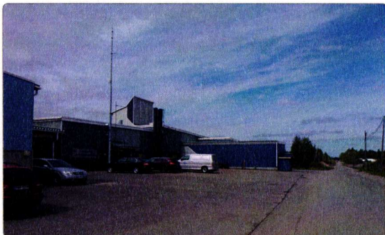
Kuva 7-7. Kuvassa on nykyinen jätevedenpuhdistamo kaakon suunnasta tarkasteltuna. Vaihtoehdon VE1 mukainen biokaasulaitos sijoittuisi kuvassa näkyvän rakennusmassan taakse. Taustalla näkyvä korkea rakenne on noin 24 metriä korkea. Märkämädätystekniikassa reaktoreiden korkeus on noin 16 m.
