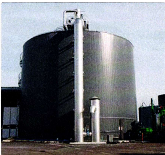
Kuva 4-13. Esimerkki teräksisestä mädätysreaktorista, jonka tilavuus on 2 400 m 3 . Kuvassa on esitetty myös ylivuotoputki.
