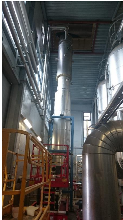
Kuva 1. Typen talteenottolaitteisto asennuksen viimeistelyvaiheessa.
