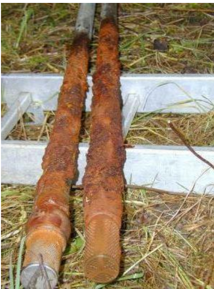
Hapan ja pehmeä kaivovesi ruostuttaa kaivossa olevia metalliputkia. Kuva: Vesikaivohuolto VIPE Oy
