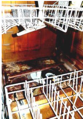
Rautapitoinen vesi voi värjätä astiat, pyykin ja kylpyhuonekalusteet ruskeiksi. Kuvassa rautapitoisen kaivoveden värjäämä astianpesukone. Kuva: Johanna Rissanen
