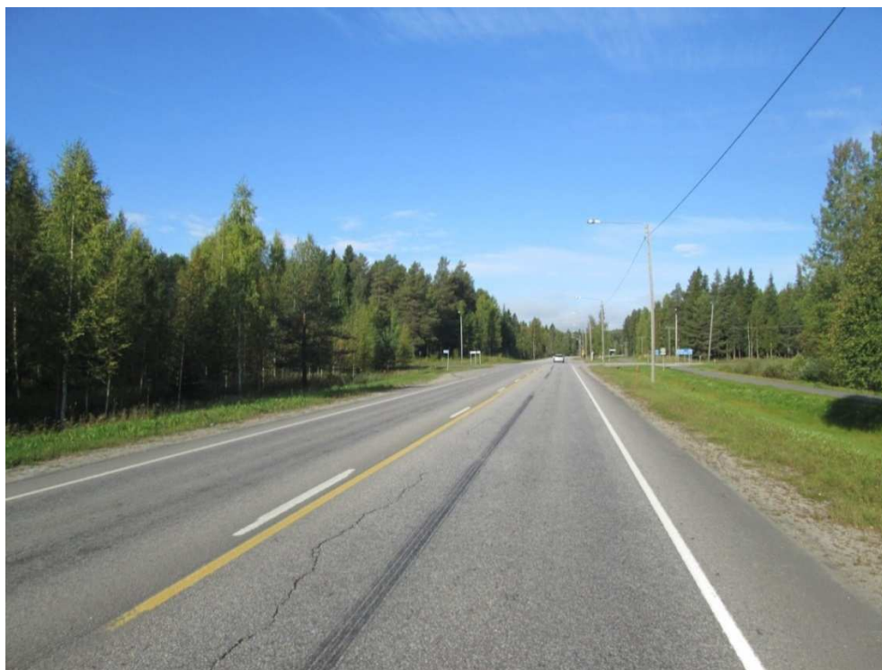
Valokuva 1. Kantatien 60 km/h nopeusrajoitusta ei ole tuettu millään rakenteellisilla tukitoimilla Kevätniementien liittymän kohdalla.
