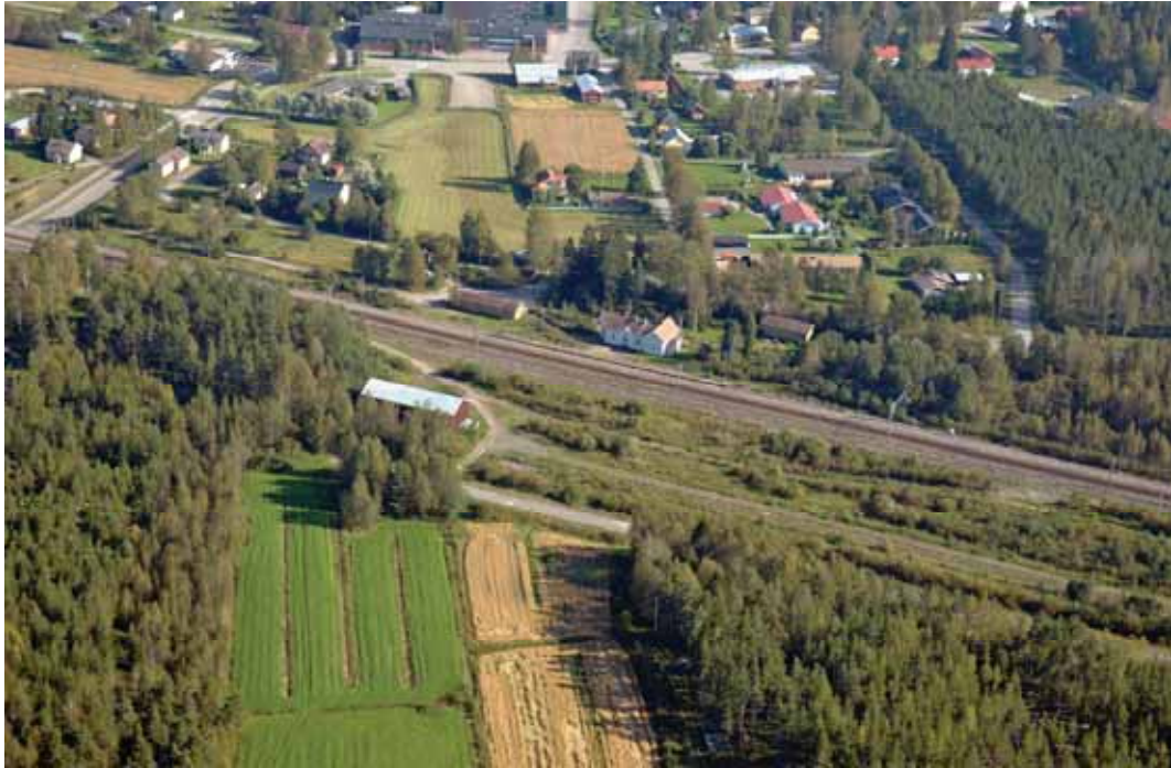
Kuva 7. Useat taajamiin sijoittuvat liikennepaikat ovat paikallisesti ja jopa valtakunnallisesti merkittäviä kulttuurihistoriallisia ympäristöjä. Kuvassa Sievin asemakylä.
