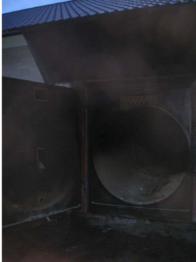
Kuva 8. Lindön kartanon 280 kW:n kattila.
