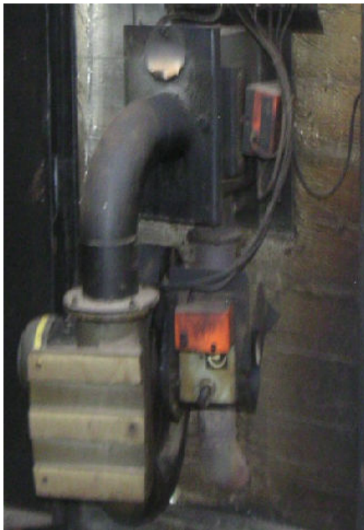
Kuva 14. Tulitorvikattilan palamisilmapiuhallin.
