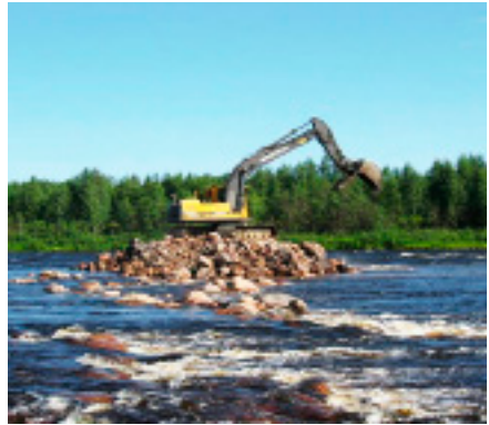
Aapiskosken kunnostusta 2005. Kuva Tapio Rautiainen.
