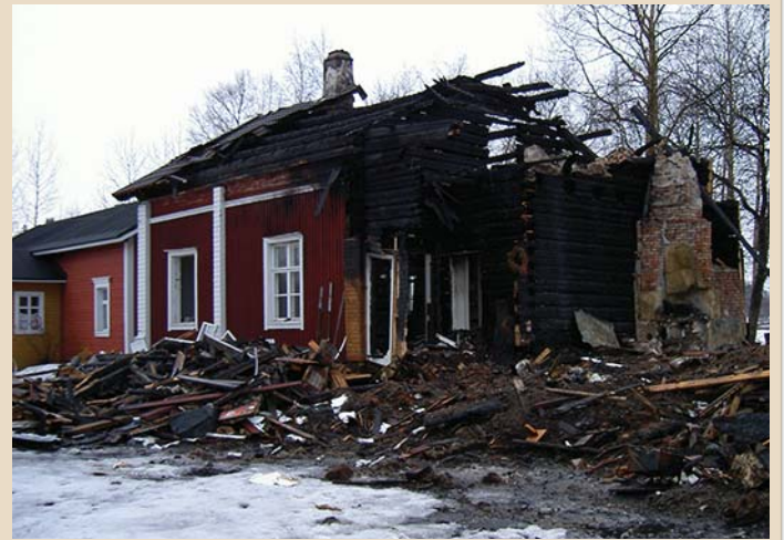
Päärakennus tulipalon jälkeen ja uusi päärakennus. Kuvat Sanna Koivisto
