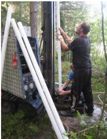
Pohjavesiputken asennus.
