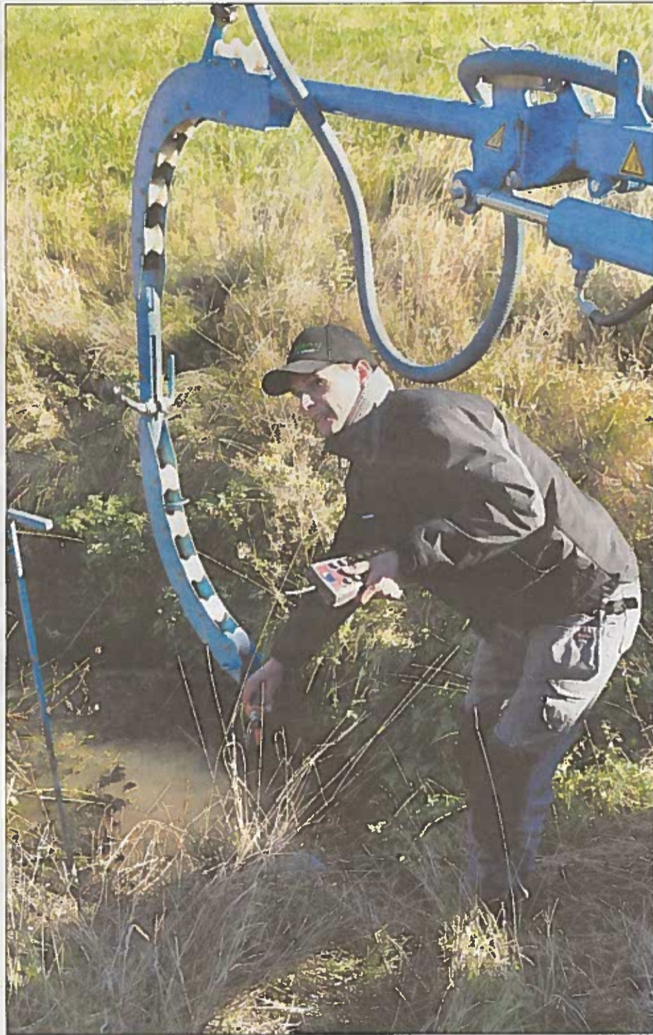
Ilkka Härmälä esittelemässä salaojan huuhtelua Vehmaan Puotilassa, jossa näytöstä oli seuraamassa yli 30 henkilöä.
