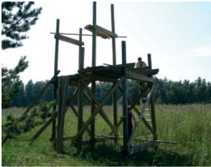
Rakenteilla oleva lintutorni. Långvassoffjården, Inkoö. Valokuva: Mauri Karonen.
