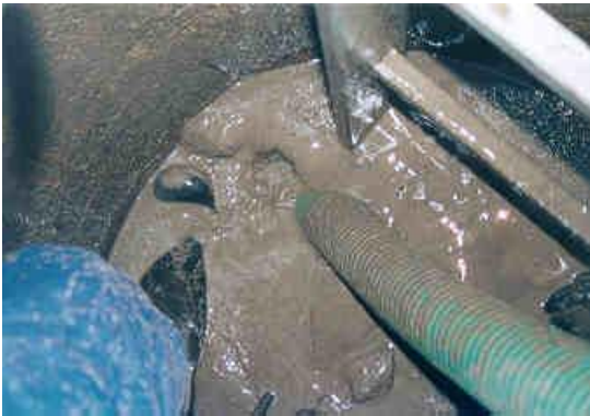
Rengaskaivon pohjalle kertynyttä lietettä poistetaan. Kuva: Pertti Virtanen
