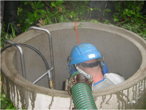
Tikkaat, kypärä ja turvaköysi ovat ehdottomia varusteita kaivon mentäessä. Kuva: Sanna Vienonen
