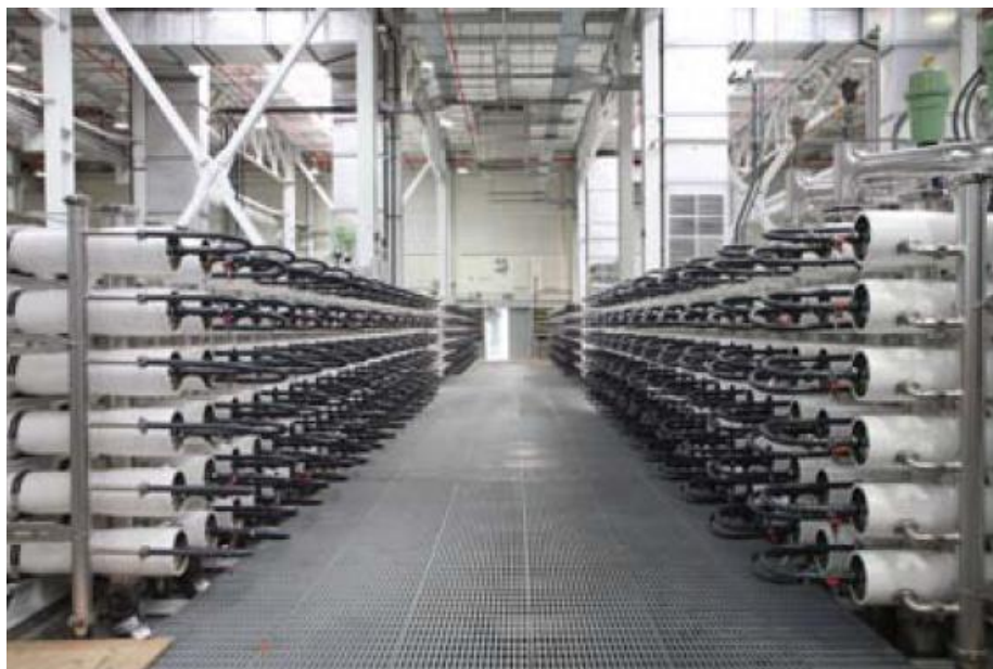
Kuva 4.8. Käänteisosmoosimoduuleja Orange Countyn laitoksella.
