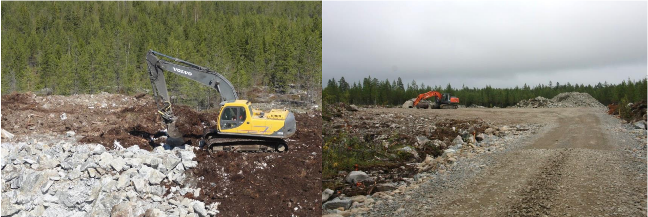
Kuvapari 5.7. Tuulivoimapaiston rakentaminen alkaa huoltoteiden ja pystytysalueiden rakentamisella (kuvat: Ville Suorsa/FCG).
