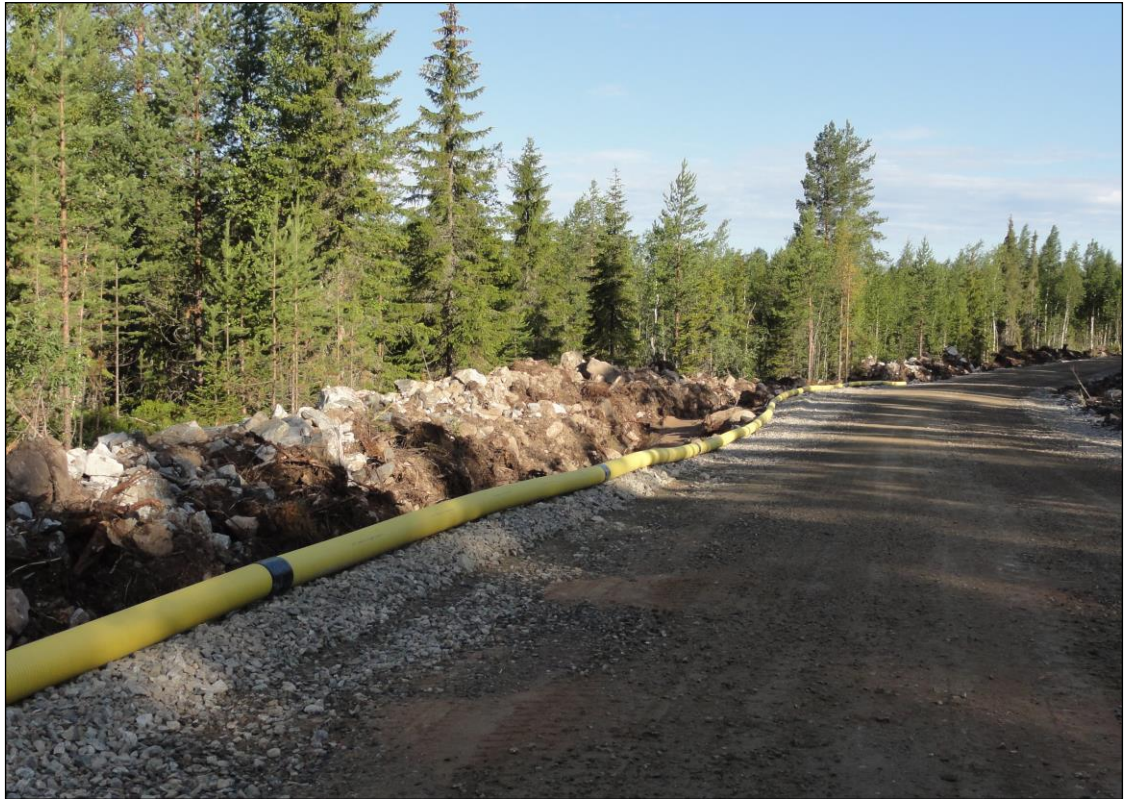
Kuva 5.5. Esimerkki tuulivoimapaiston rakennus- ja huoltotiestä. Teitä käytetään muun muassa betonin, soran ja voimaloiden komponenttien kuljetuksiin sekä tuulivoimapaiston käyttövaiheessa huoltoajoihin. Maakaapeli sijoitetaan ojakaivantoon tien reuna-alueelle (Kuva: Ville Suorsa / FCG).
