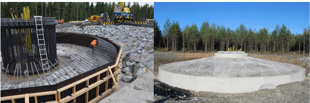
Kuvapari 5.9. Tuulivoimalan perustusten rakentamista. (Kuvat: Leila Väyrynen, FCG)
