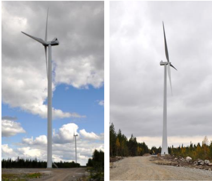
Kuva 5.1. Vasemmalla on esimerkki teräslieriötornista ja oikealla rakenteilla olevan hybriditornista. (Kuvat: Leila Väyrynen, FCG)
