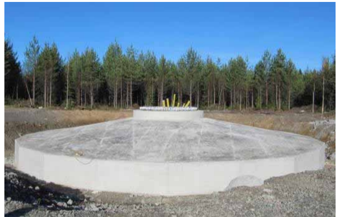
Kuva 4.5. Tuulivoimalan perustusten rakentamista. (Kuvat: Leila Väyrynen, FCG)
