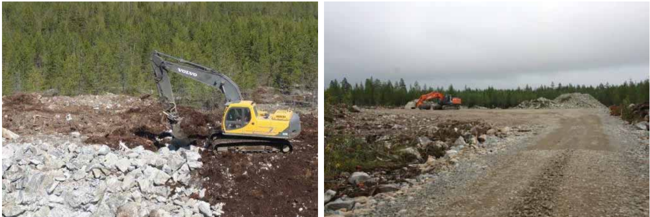
Kuva 4.15. Tuulivoimapuiston rakentaminen alkaa huoltoteiden ja pystytysalueiden rakentamisella.
