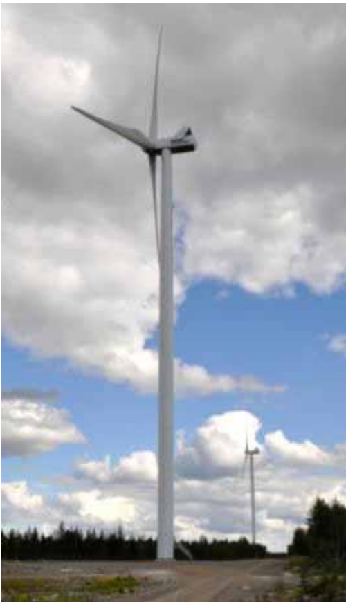
Kuva 4.2. Vasemmalla teräslieriötorni ja oikealla rakenteilla oleva hybriditorni.
