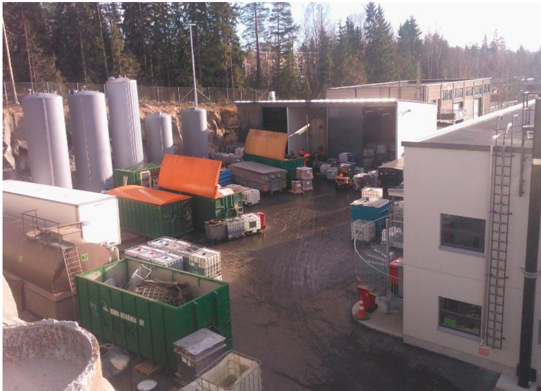
Kuva 1.3. Takapiha, käsittelyhalli oikealla ja nestemäisten jätteiden varastosäiliöt vasemmalla.
