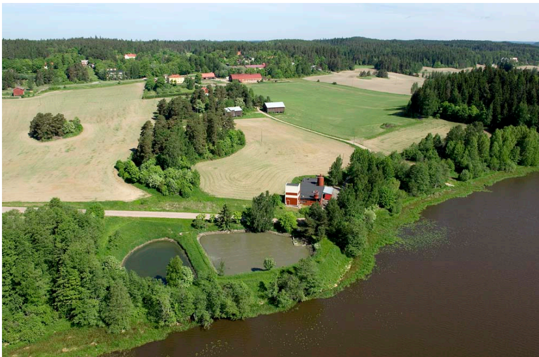
Kuva 23. Vihdin kirkonkylän jätevedenpuhdistamo (punainen rakennus rannan läheisyydessä. Kuvassa näkyvät altaat kuuluvat jätevedenpuhdistamon toimintaan. (Kuva: Aero-Kuva Oy).
