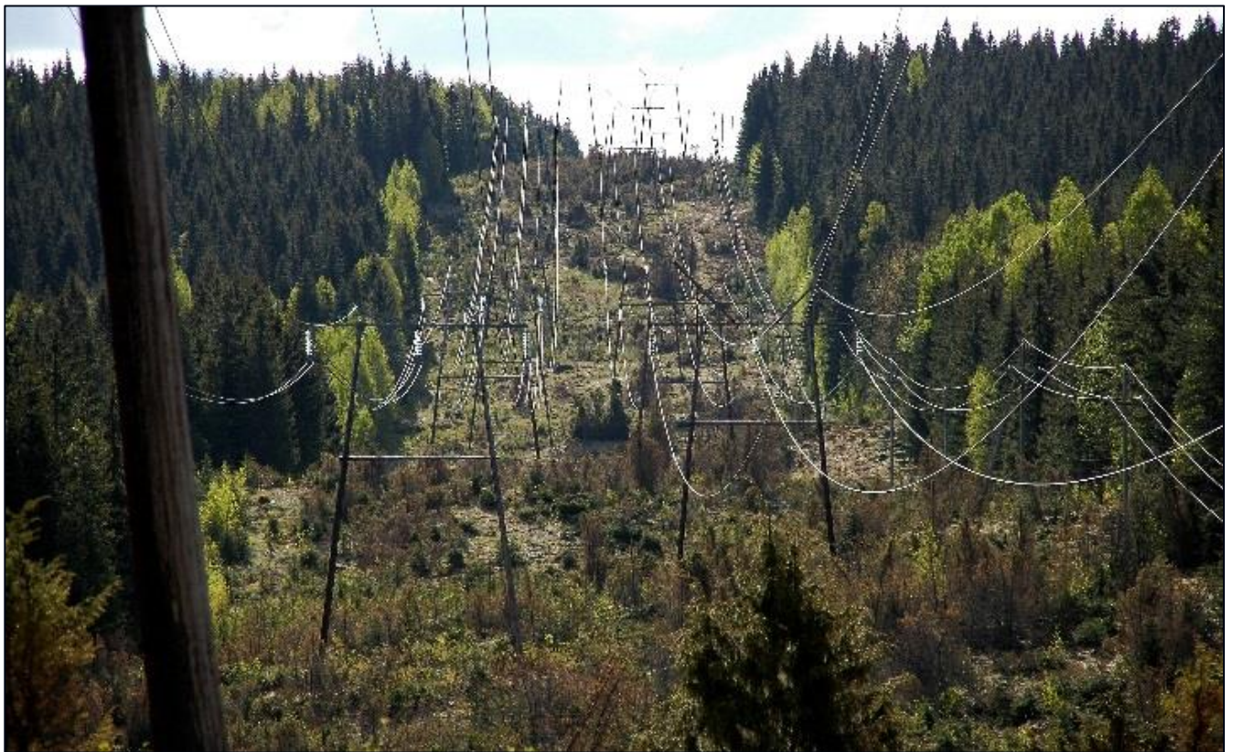
Kuva 3.7. Esimerkki valikoivasta raivauksesta.
