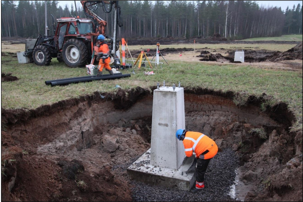
Kuva 3.4. Pylvään perustuselementin asentaminen.
