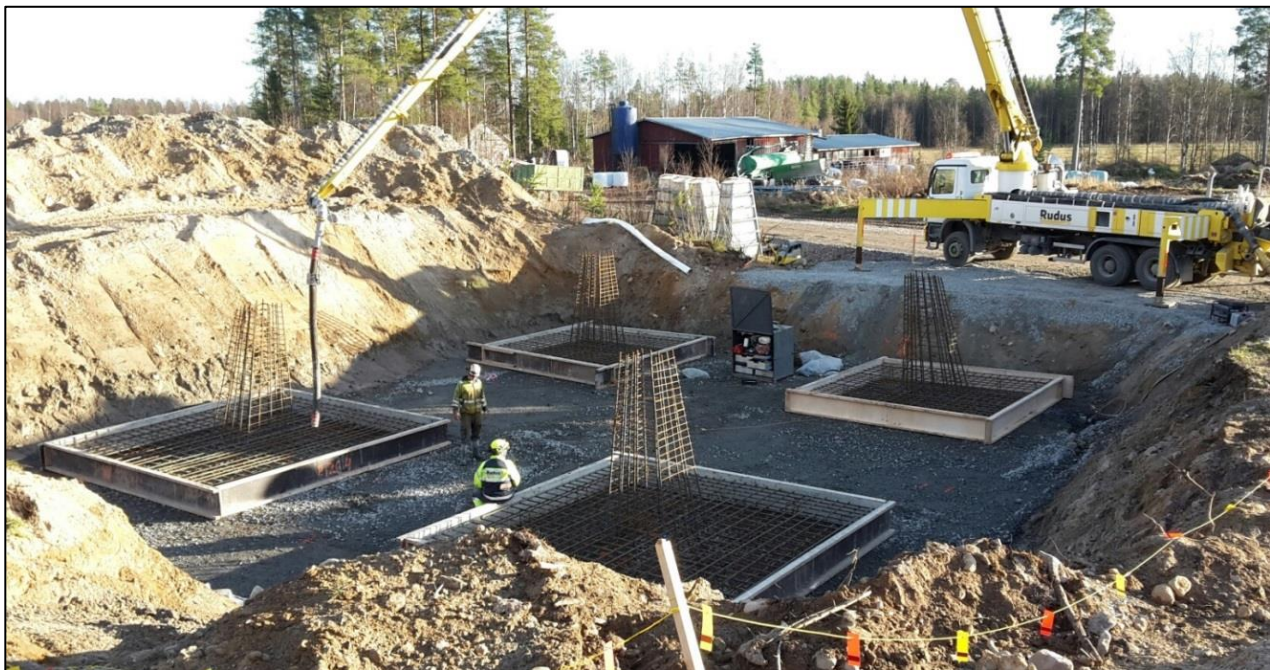
Kuva 3.5. Vapaasti seisovan pylvään perustuksen pohjatöitä.
