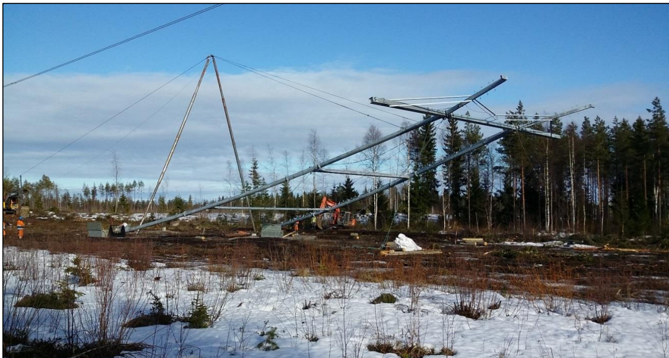
Kuva 3.6. Voimajohtopylvään pystytys.
