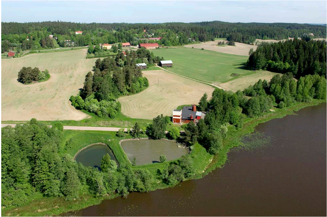
Kuva 19. Vihdin kirkonkylän jätevedenpuhdistamo (punainen rakennus rannan läheisyydessä. Kuvassa näkyvät altaat kuuluvat jätevedenpuhdistamon toimintaan. (Kuva: Aero-Kuva Oy).
