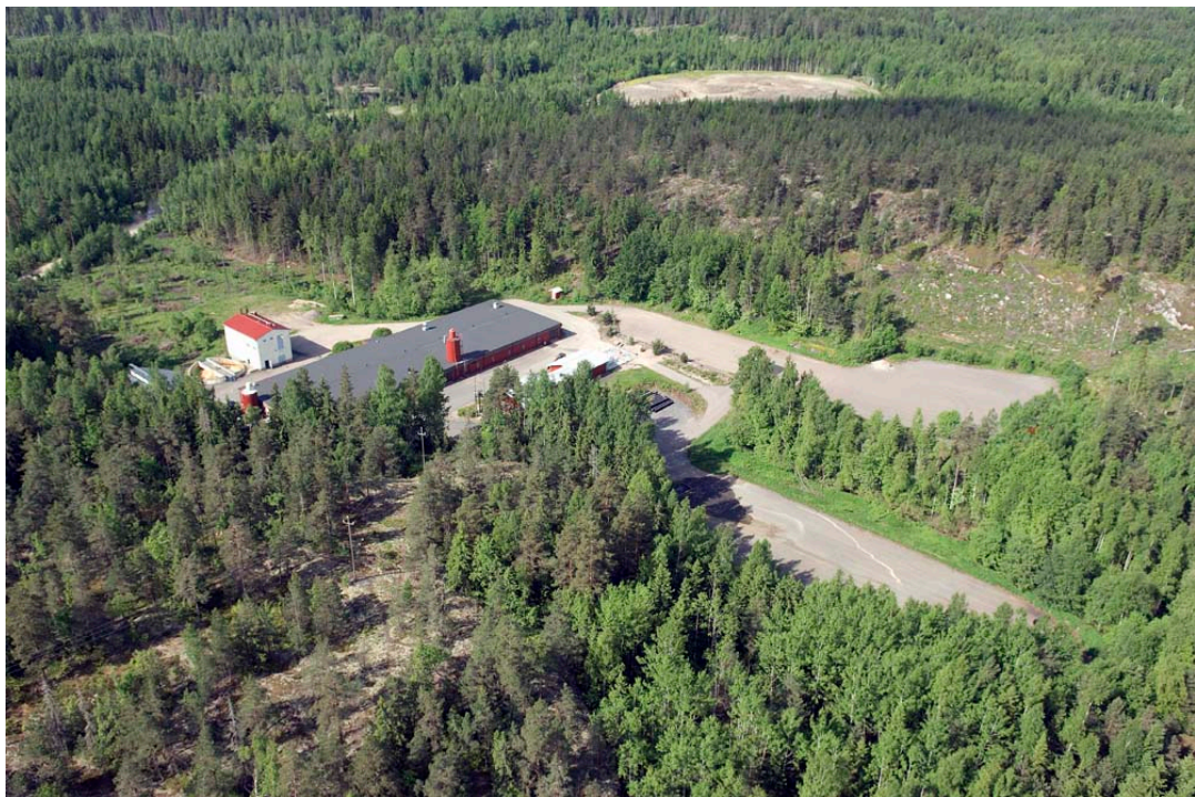
Kuva 18. Nummelan jätevedenpuhdistamo. (Kuva: Aero-Kuva Oy).
