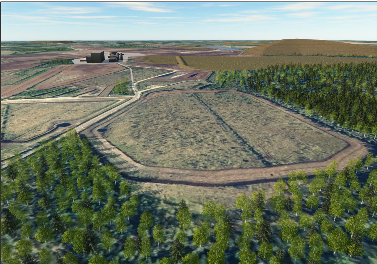
Kuva 168. Päivänevan rikastamoalue mallinnettu 3D:nä. Rikastamo- ja kaivostoiminta päättynyt ja alueilla alkanut maisemointityöt. Kuvattu Näätinkiojan kohdalta pohjoiseen.
