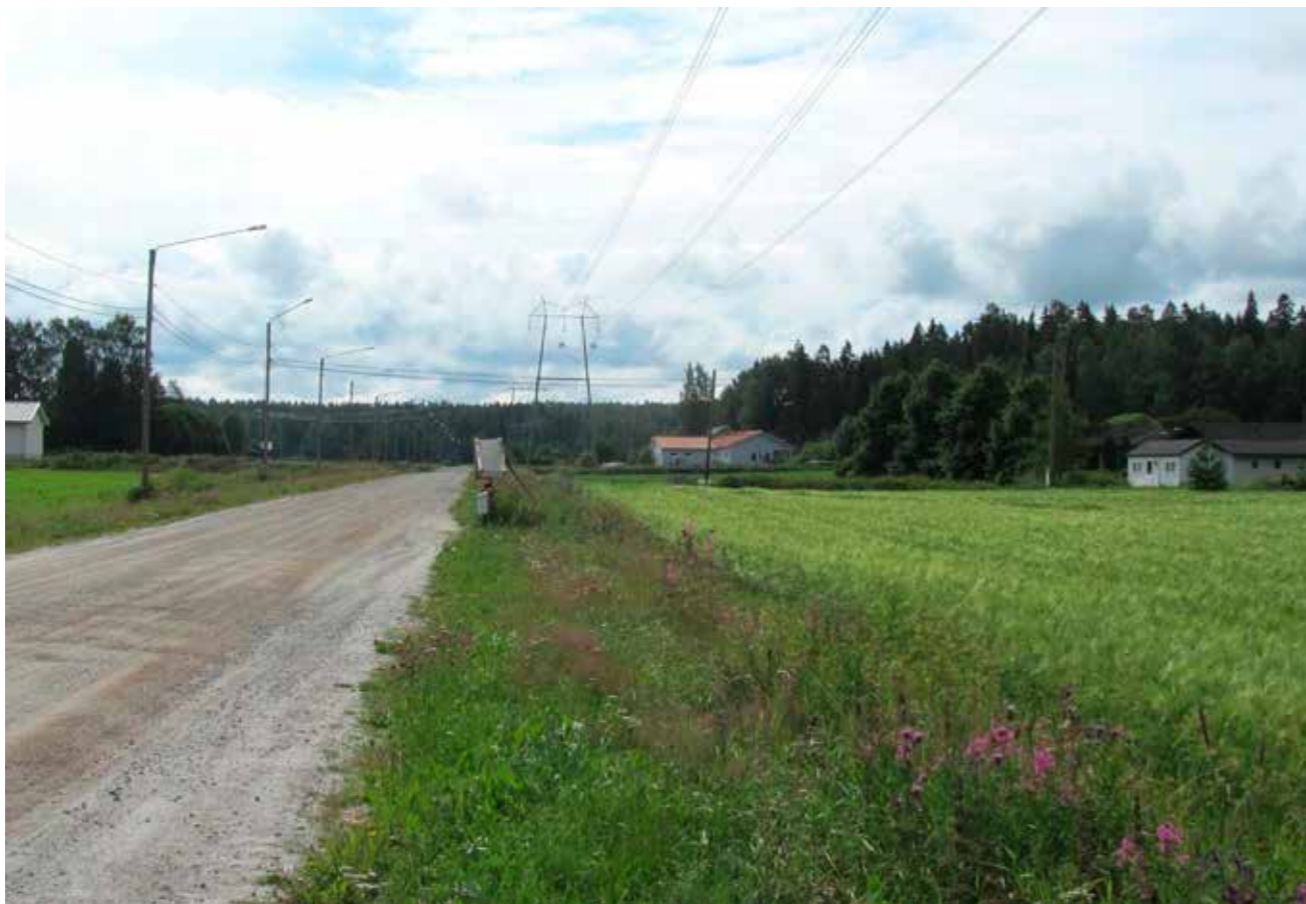
Kuva 38. Fladan- ja Vikby-vaihtoehdot kulkevat olemassa olevan kylärakenteen läpi Yttersundomin kylässä.
