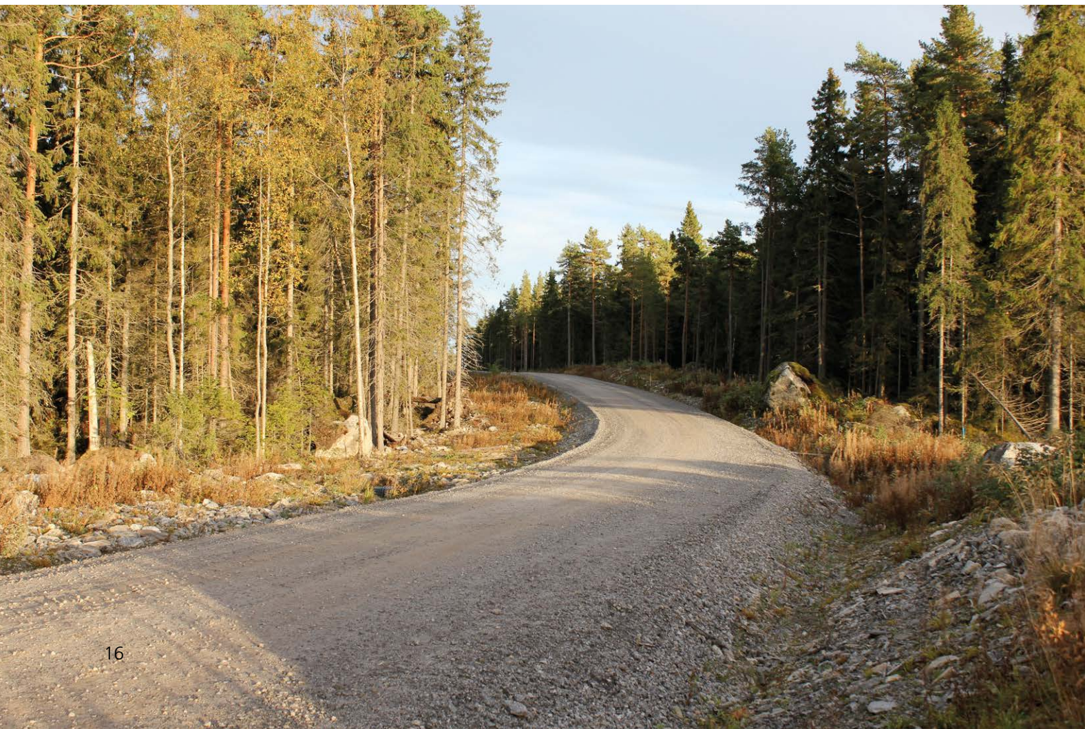
Kuva 4-7. Tuulivoimalan huoltotie – Äjen, Vaasa.
