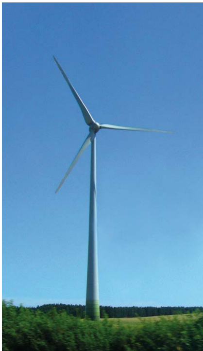
Kuva 4-3. Kuva lieriötornirakenteisesta tuulivoimalasta.
