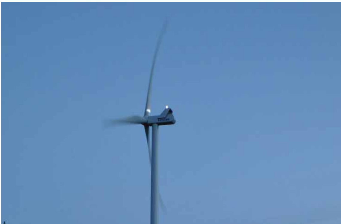
Kuva 8.10. Putaankankaan voimalan lentoestevalot.
