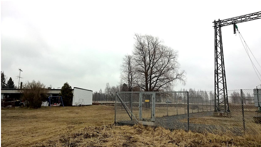
Kuva 16-6. Jurvan sähköasema ja sen pohjoispuolella sijaitseva rakennus. (Kuva: Suvu Järvinen/FCG)
