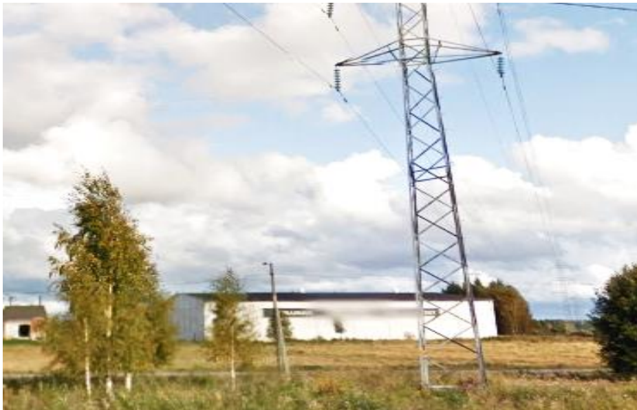
Kuva 4-16. Nori-Jurva voimajohto on yhden virtapiirin 110 kV voimajohto, joka on sijoitettu vapaasti seisoviin pylväisiin Larvaloukosta Jurvan sähköasemalle asti. Pylväissä on myös jo puretun 45 kV:n voimajohdon käytöstä poistettuja johtimia jäljellä, jotka korvataan nyt suunniteltavalla 110 kV:n voimajohdolla. Kuva on otettu Vaasantieltä idän suuntaan. Taustalla näkyy Hiipakan huonekalutehdas. Seinäjoki-Jurva voimajohto sijoitetaan kyseisiin pylväisiin 2,3 kilometrin matkalla ennen sähköasemaa.
