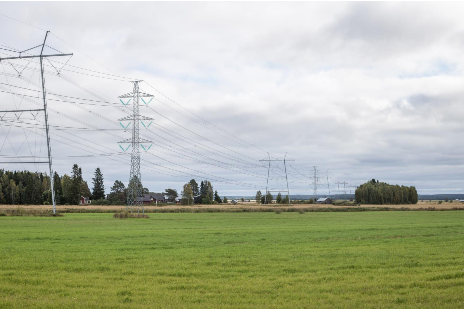
Kuva 19-2. Havainnekuva Seinäjoki–Jurva 110 kV voimajohdosta (110+110 kV) vapaasti seisovassa pylväässä (toinen ja neljäs pylväs vasemmalta) osuudella A jo olemassa olevan Seinäjoki–Tuovila -voimajohdon (ensimmäinen ja kolman pylväs vasemmalta) rinnalla. (Kuva: Mika Riekk / FCG)
