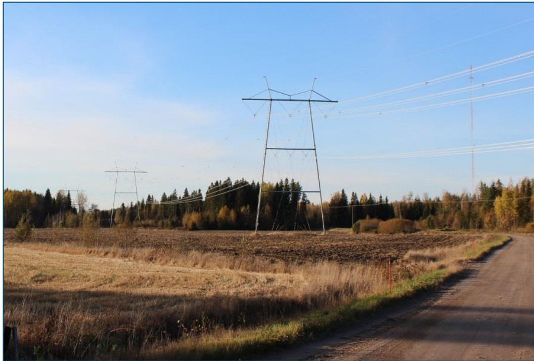
Kuva 4-4. Seinäjoki–Tuovila 400+110 kV –voimajohto. (Kuva: Hans Vadbäck / FCG)
