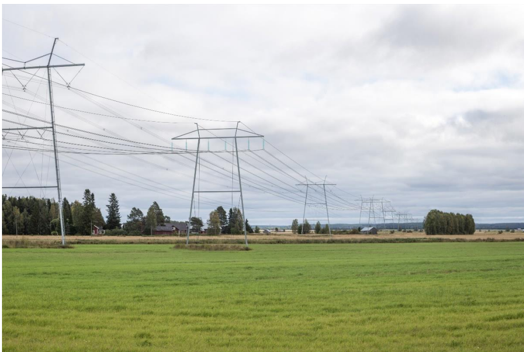
Kuva 11-8. Valokuviasovite suunnitellusta Seinäjoki-Jurva 110 kV voimajohtosta nykyisen Seinäjoki-Tuovila 400+110 kV -voimajohtoon vieressä. Kuva on otettu Kasarinloukon Toivon alueelta kohti kaakkoa. Kuvassa voimajohto ylittää Ilmajoen Alajoen viljelyalueen. Ylhäällä on alkuperäinen valokuva ja alhaalla sen pohjalta tehty sovite. (Kuva: Mika Rieki / FCG)
