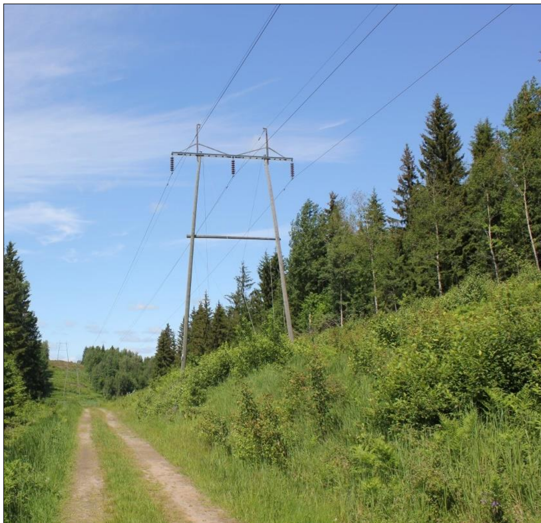
Kuva 4-8 Esimerkki yhden virtapiirin 110 kV ilmajohtosta. Johtoaukealla esiintyy yleensä puun taimia ja pensasmaista kasvillisuutta. Johtoauekan vieressä on huoltotie (Kuva: Mattias Järvinen / FCG).
