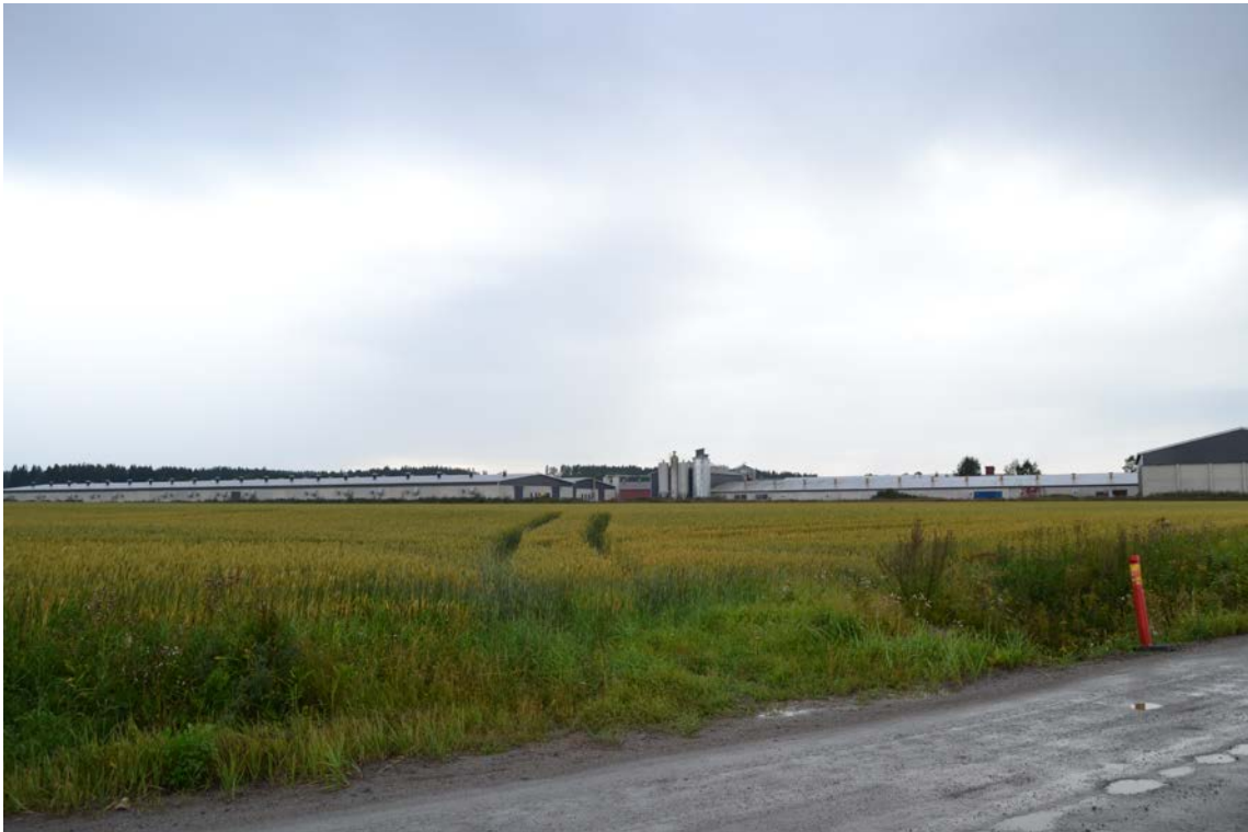
Kuva 6.10 Näkymä tilalle Ahokyläntien itäpuolelta. Pitkät rakennukset ovat broilerhalleja.
