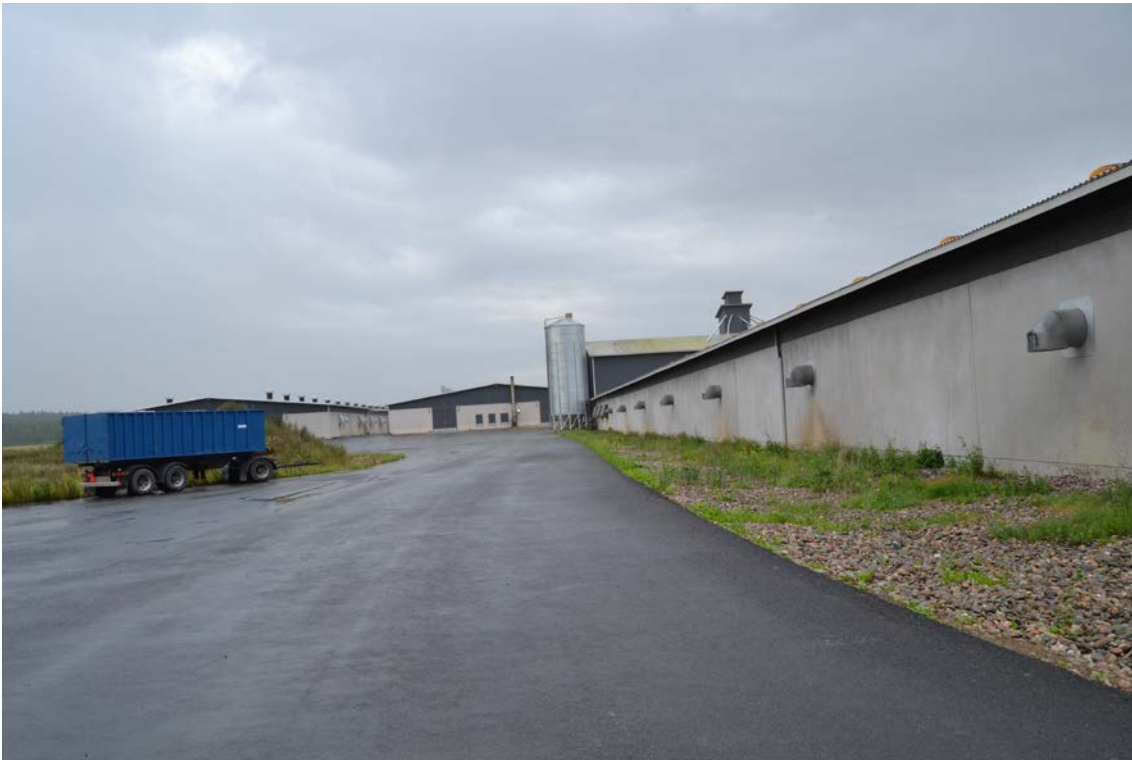
Kuva 6.14 Saaren tilan tuotantorakennuksia. Käyrät torvet seinissä ovat poistoilmapiutkia.
