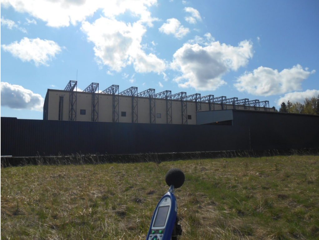
Kierrätyslaitos pohjoiseen päin (rakennus on energiajätteen murskaushalli).
