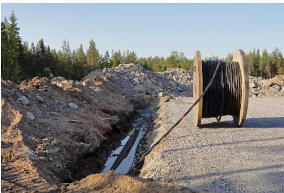
Kuvapari 4.12. Maakaapelit upotetaan huoltoteiden yhteyteen (kuvat: Ville Suorsa/FCG).
