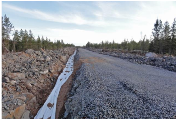
Kuvapari 4.12. Maakaapelit upotetaan huoltoteiden yhteyteen (kuvat: Ville Suorsa/FCG).
