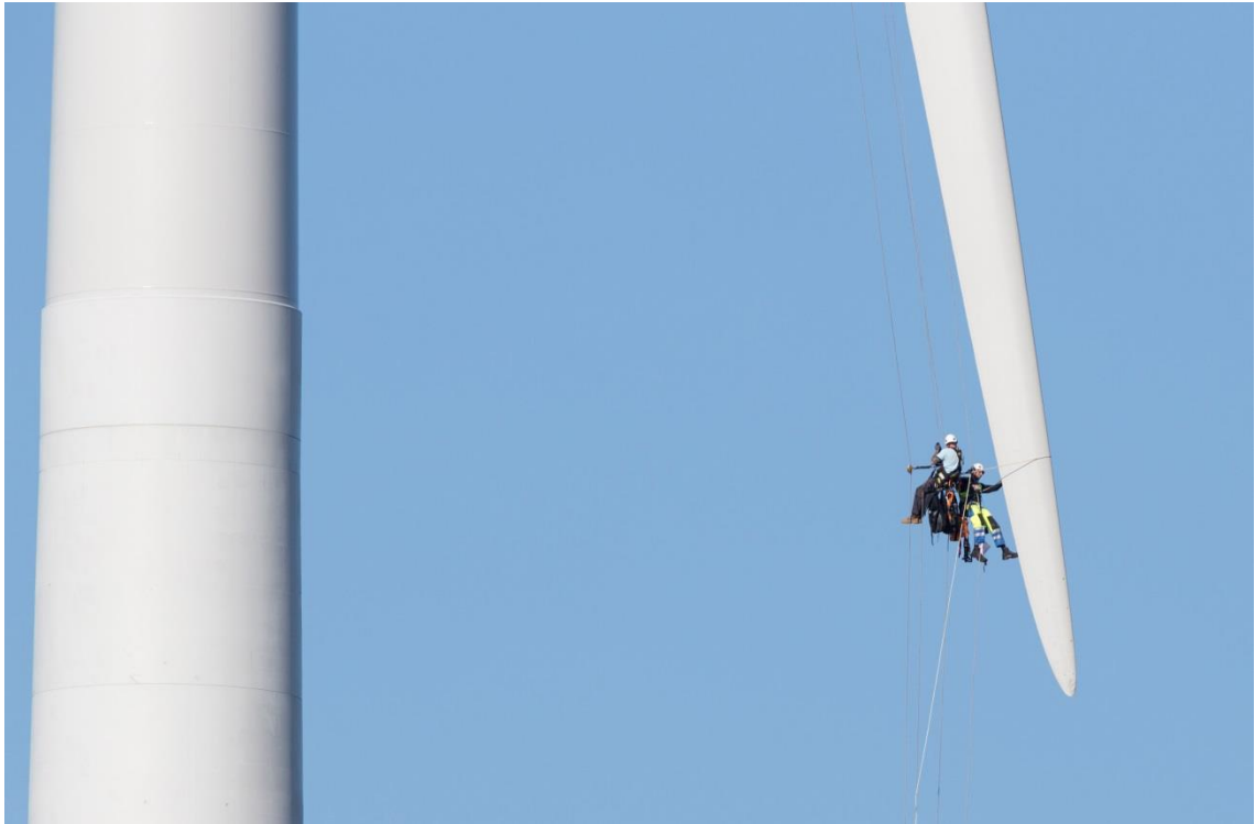
Kuva 4.17. Tuulivoimalan huoltotoimenpiteitä. (Kuva: Ville Suorsa, FCG).
