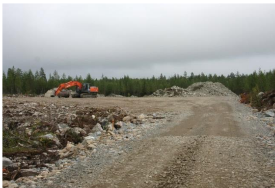
Kuvapari 4.11. Huoltoteiden ja pystytysalueiden rakentamista (kuvat: Ville Suorsa/FCG).
