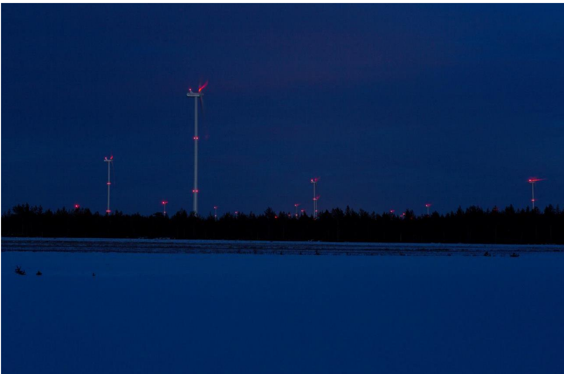
Kuva 4.5. Kiinteät punaiset lentoestevalot. (Kuva: Ville Suorsa, FCG)
