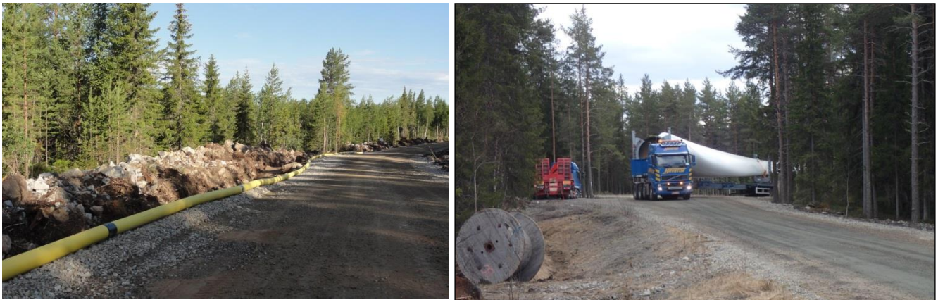
Kuva 4.8. (Vasemmalla) Esimerkki tuulivoimapuiston rakennus- ja huoltotiestä. Teitä käytetään muun muassa betonin, soran ja voimaloiden komponenttien kuljetuksiin sekä tuulivoimapuiston käyttövaiheessa huoltoajoihin. Maakaapeli sijoitetaan ojakaivantoon tien reuna-alueelle. (Oikealla) Tuulivoimalan osia kuljetetaan erikoiskuljetuksina. (Kuvat: Ville Suorsa / FCG).
