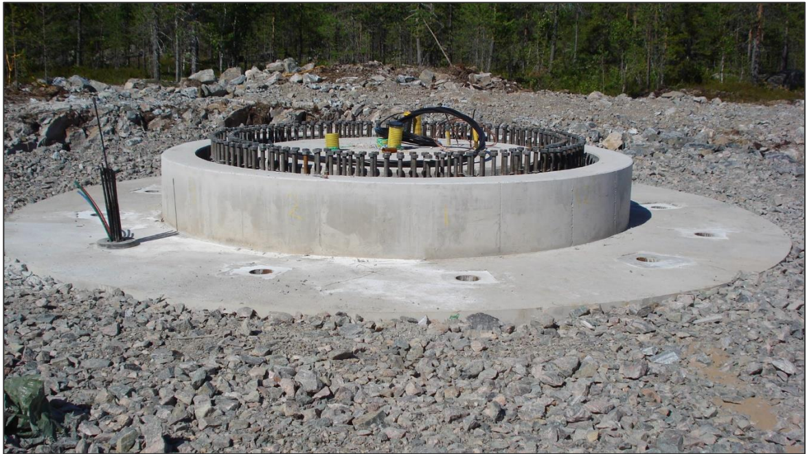
Kuva 3-6. Kallioankkuroitu teräsbetoniperustus (YIT Suomi Oy)
