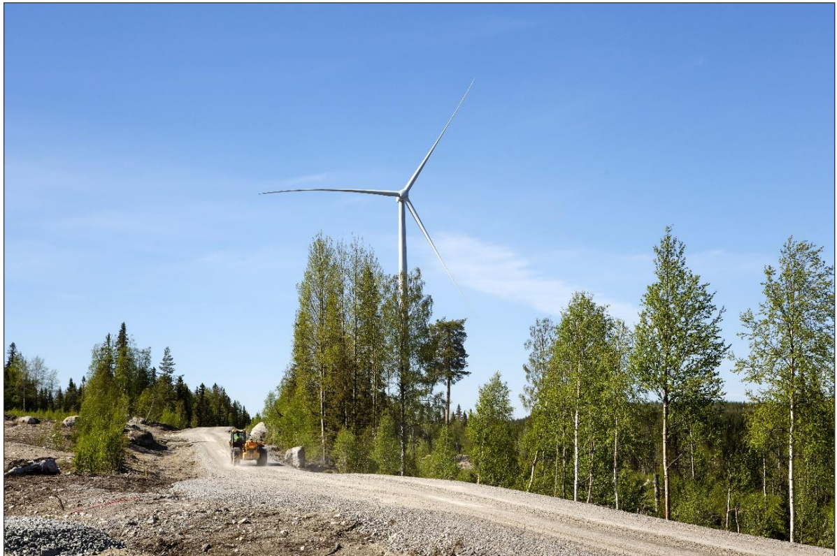
Kuva 3-9. Esimerkkikuva tuulivoimalan huoltotiestä (YIT Suomi Oy).
