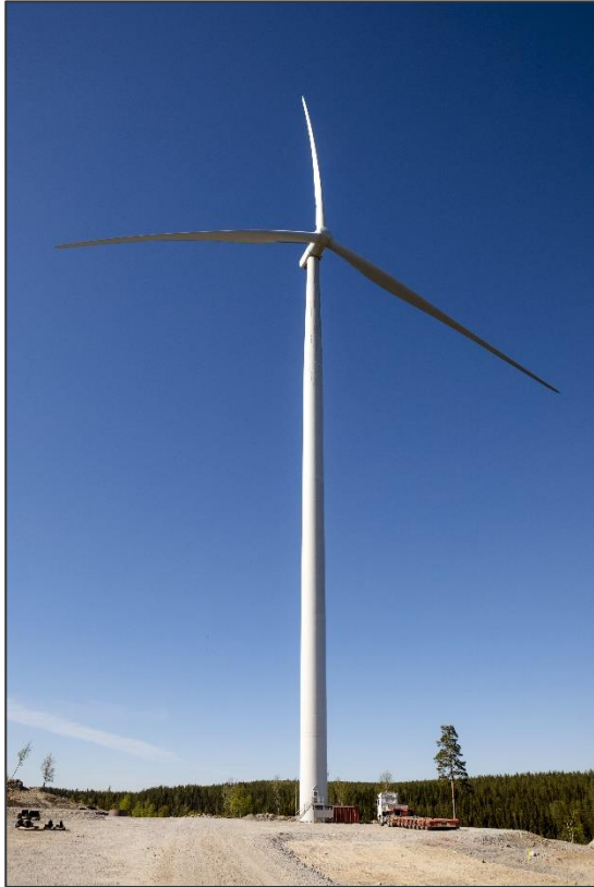
Kuva 3-4. Tuulivoimala terästornilla (YIT Suomi Oy).
