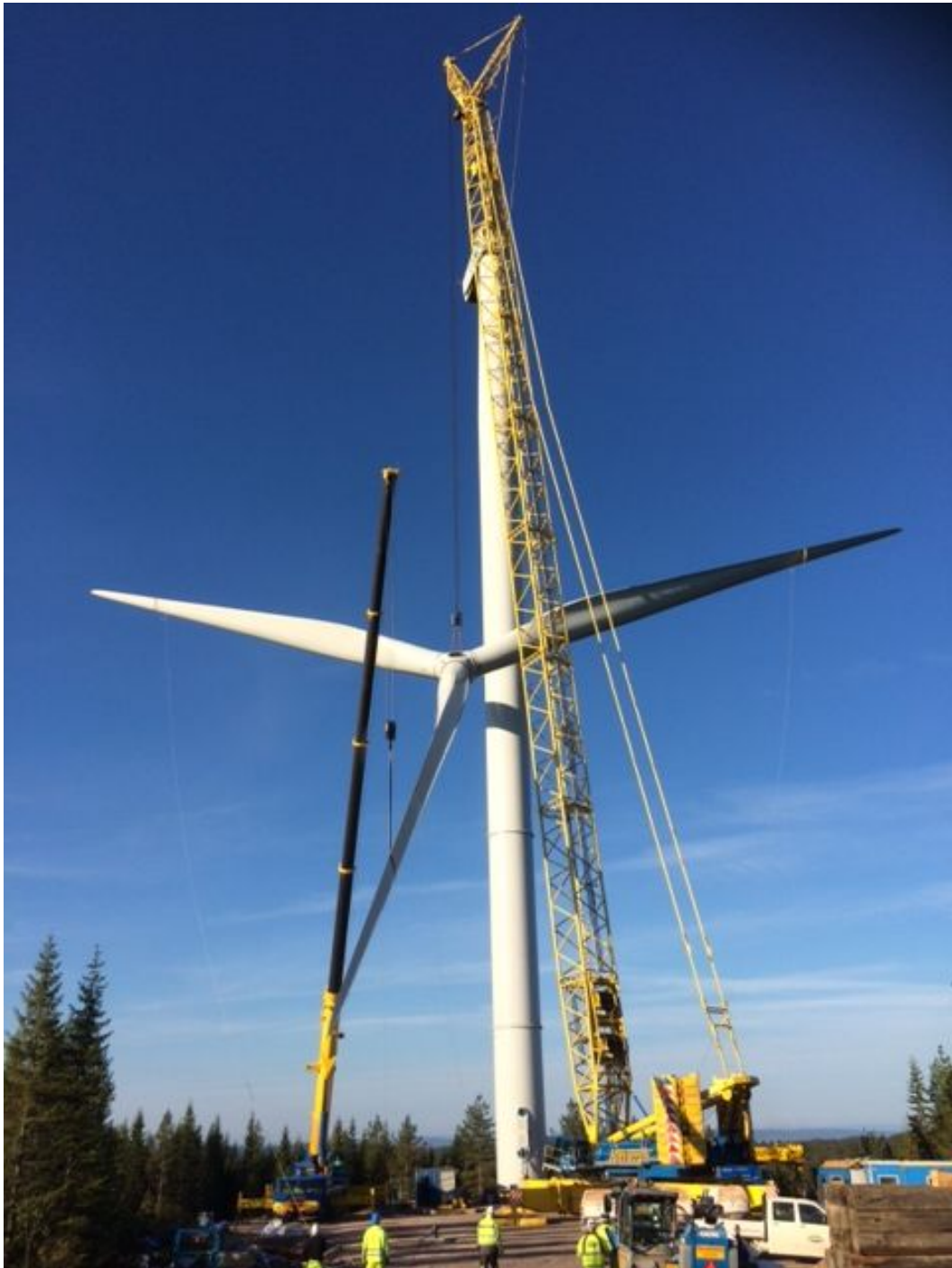
Kuva 14. Roottorin nosto.
