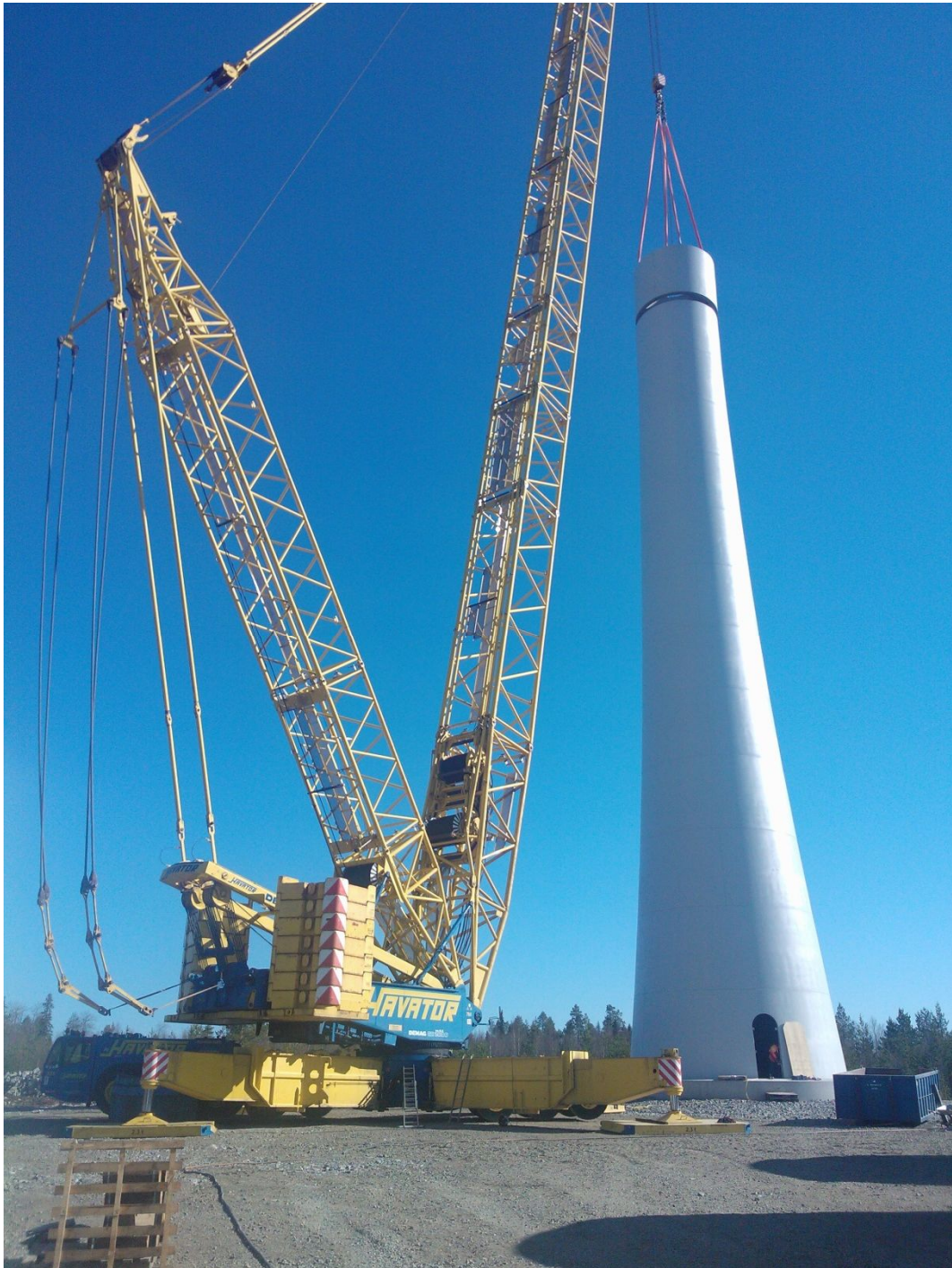
Kuva 11. Torni alkaa rakentua.
