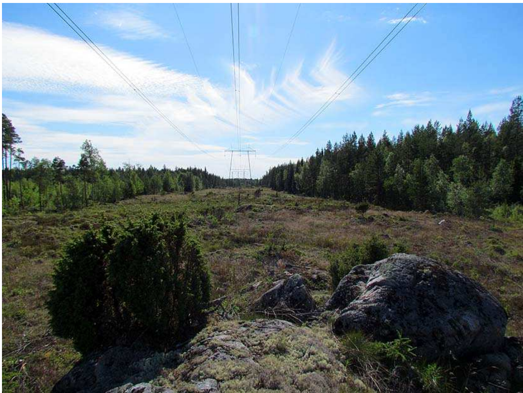
Kuva 4. Tarkastettua sähkölinjaa hankealueen pohjoispuolella.
