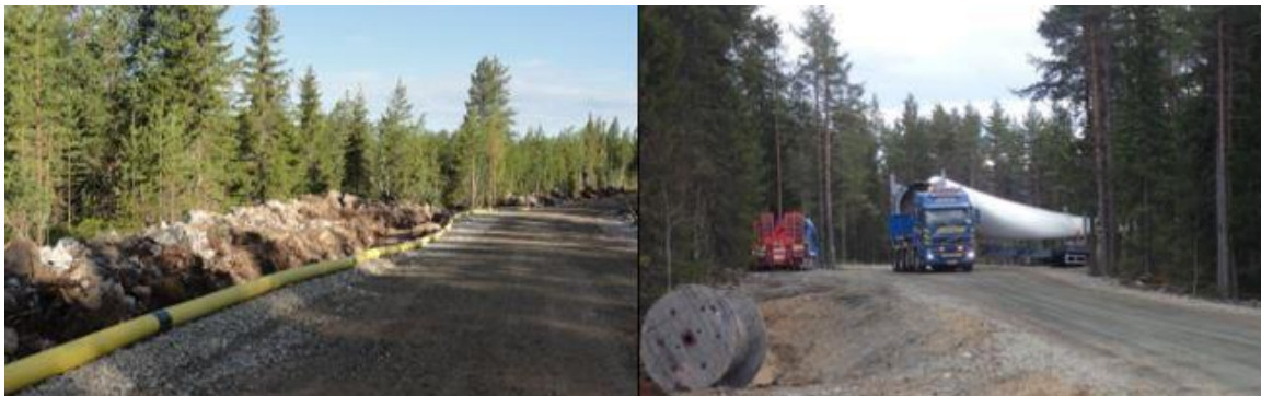
Kuva 5-7. Vasemmalla esimerkki tuulivoimapuiston rakennus- ja huoltotiestä. Teitä käytetään muun muassa betonin, soran ja voimaloiden komponenttien kuljetuksiin sekä tuulivoimapuiston käyttövaiheessa huoltoajoihin. Maakaapeli sijoitetaan ojakaivantoon tien reuna-alueelle. Oikealla tuulivoimalan osia kuljetetaan erikoiskuljetuksina. (Ville Suorsa, FCG).
