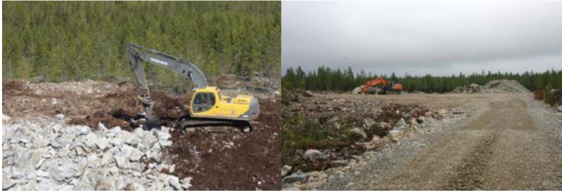
Kuva 5-11. Tuulivoimapuiston rakentaminen alkaa huoltoteiden ja pystytysalueiden rakentamisella (Ville Suorsa, FCG).
