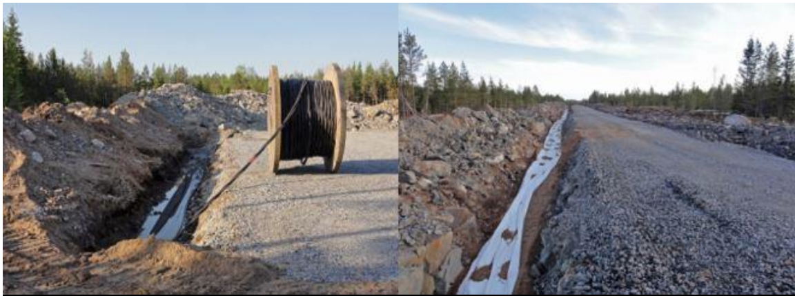
Kuva 5-12. Maakaapelit upotetaan huoltoteiden yhteyteen (Ville Suorsa, FCG).
