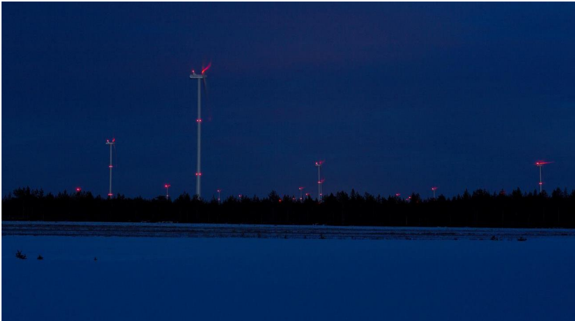
Kuva 5-4. Kiinteät punaiset lentoestevalot (Ville Suorsa, FCG).
