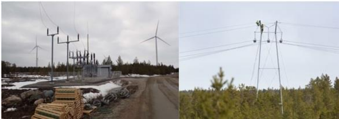
Kuva 5-16. Sähköaseman ja voimajohdon rakentamista (Ville Suorsa, FCG).
