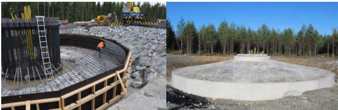
Kuva 5-13. Tuulivoimalan perustusten rakentamista (Leila Väyrynen, FCG).
