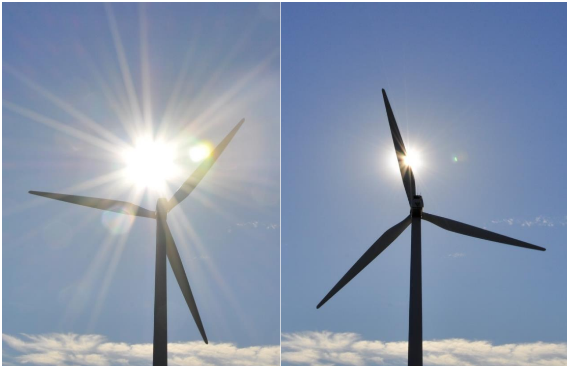
Kuva 20-13. Tuulivoimaloiden lavat aiheuttavat pyöriessään vilkkumista ja varjon välkkymistä aurinkoisella säällä.
