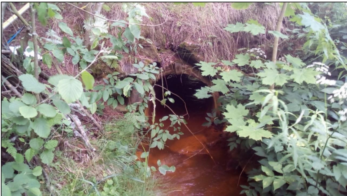
Kuva 41. Havaintopaikka KA-VIR4, ojarumpu.
