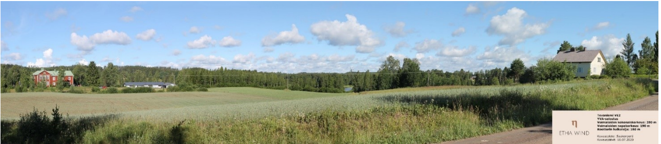
Kuva 5.53. Havainnekuva Saukonperästä (VE 2). Etäisyys voimaloihin on noin 7,0 – 9,5 kilometriä. Voimalat näkyvät maisemassa. Kuvauspisteen kohdalla hanke muuttaa maisemaa hieman.
