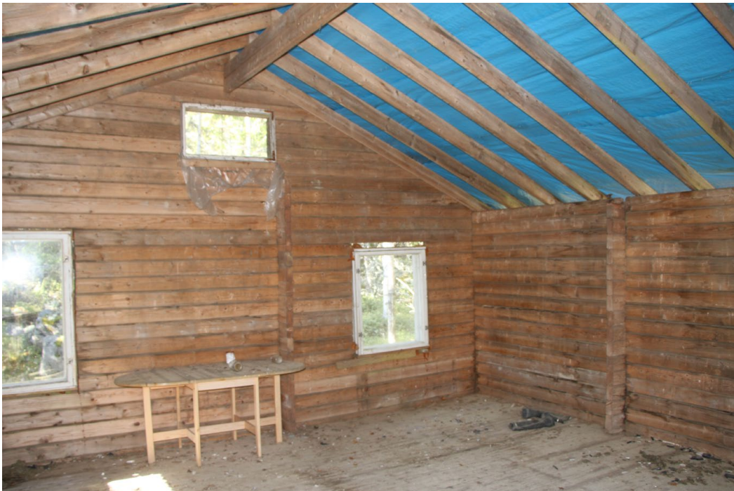
Rakennus B sisäkuva
