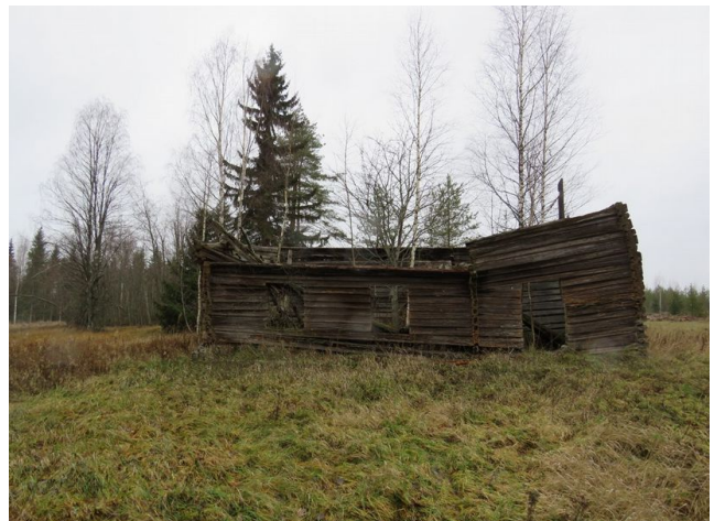
Kuva 39. Rakenne 1, talo pohjoiseen.
