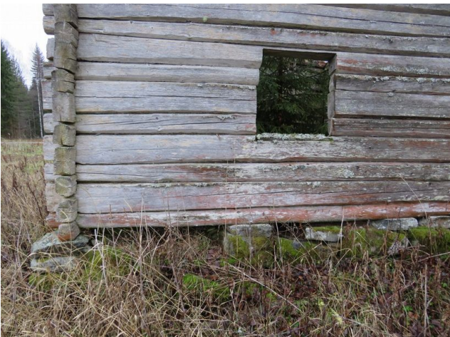
Kuva 38. Rakenne 1, talon koillisnurkka.
