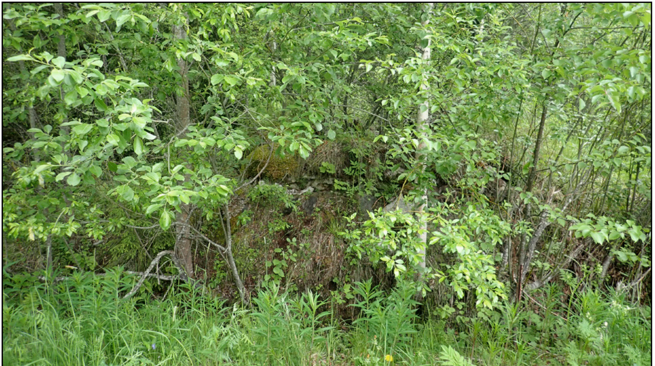
Kuva 26. Inventoinnissa havaittu kellari pusikoituneessa maastossa. Pohjoiseen.
