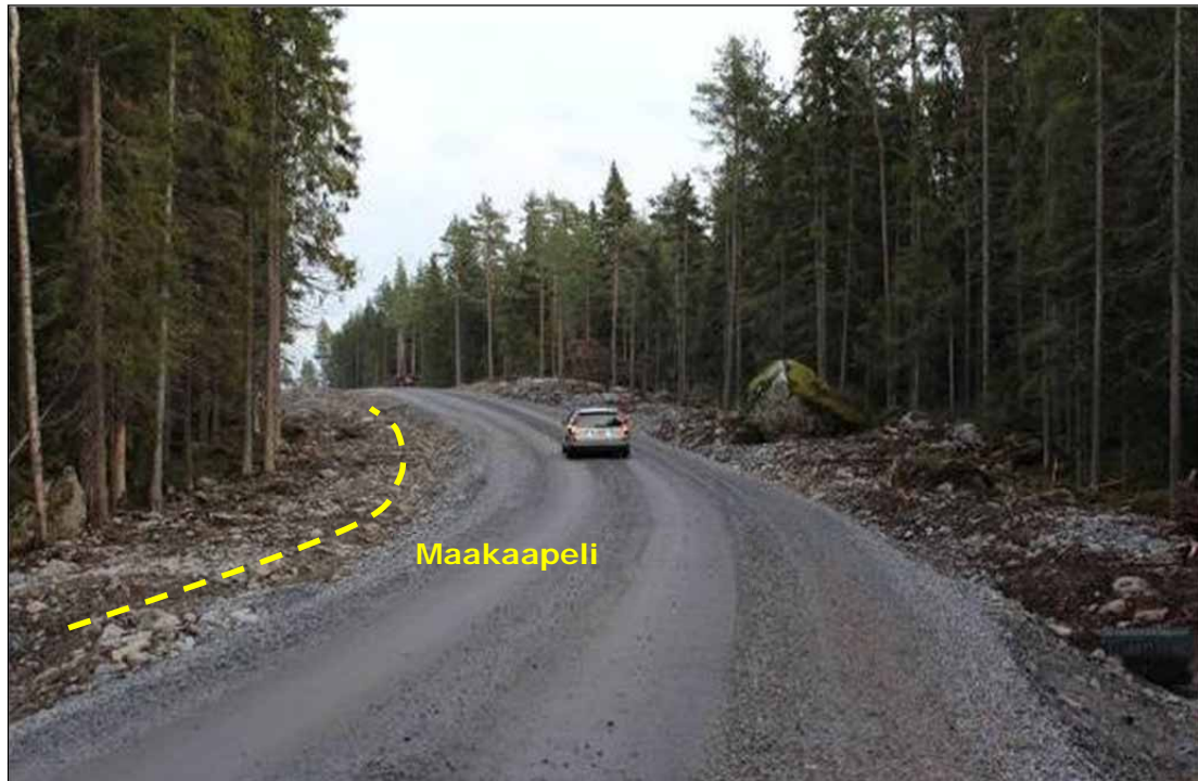
Kuva 5.5. Esimerkki tuulivoimapuiston rakennus- ja huoltotiestä. Teitä käytetään muun muassa betonin ja soran sekä voimaloiden komponenttien kuljetuksiin. Tuulivoimapuiston käyttövaiheessa teitä käytetään mm. vuosittaisissa huolloissa. Maakaapelin oja on sijoitettu tien vasemmalle puolelle (Kuva: Hans Vadbäck / FCG).
