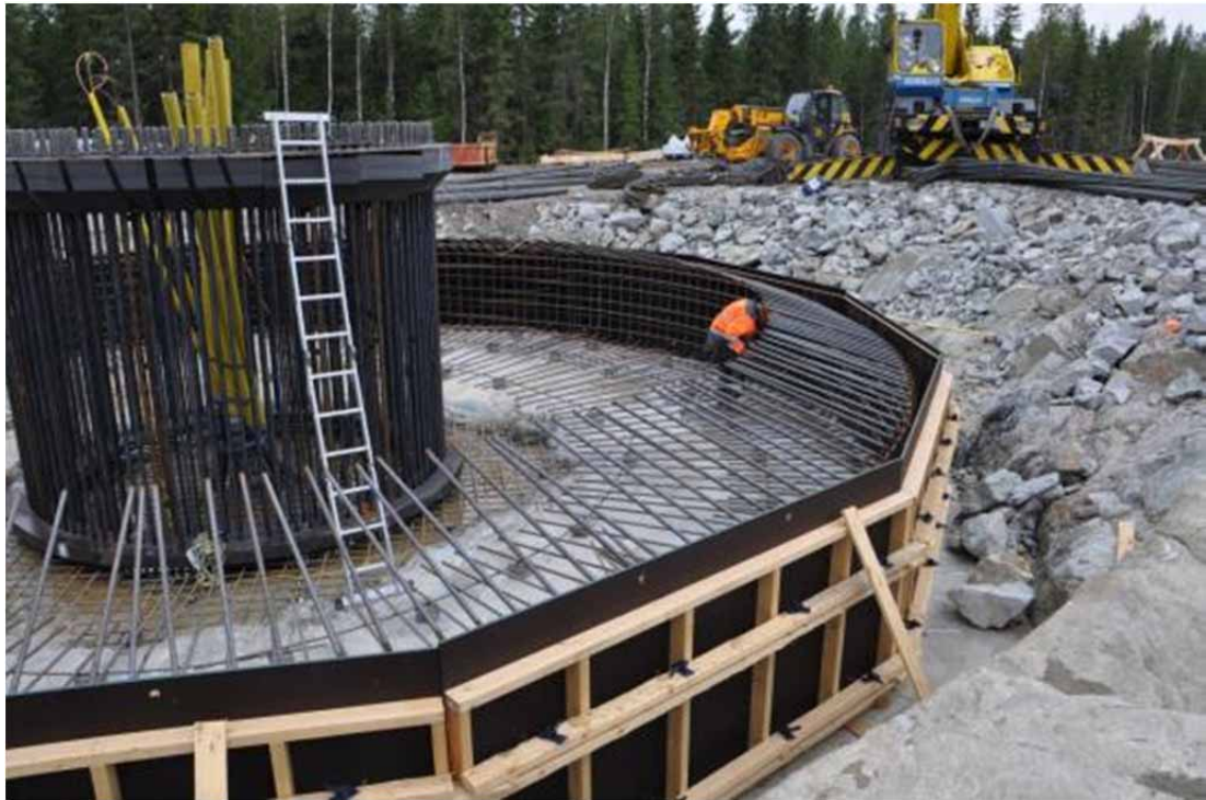
Kuva 5.9. Tuulivoimalan perustusten rakentamista. (Kuva: Leila Väyrynen, FCG)
