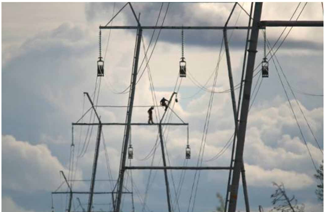
Kuva 5.10. 220 kV voimajohdon rakentamista. (Kuva: Ville Suorsa, FCG)
