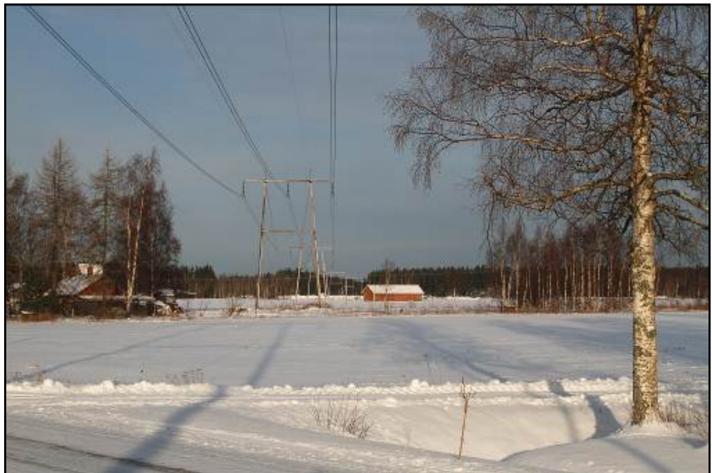
Kuva 5.2. Fingrid Oy:n uusittava 220 kV voimajohto Dagsmarkin kohdalla.
