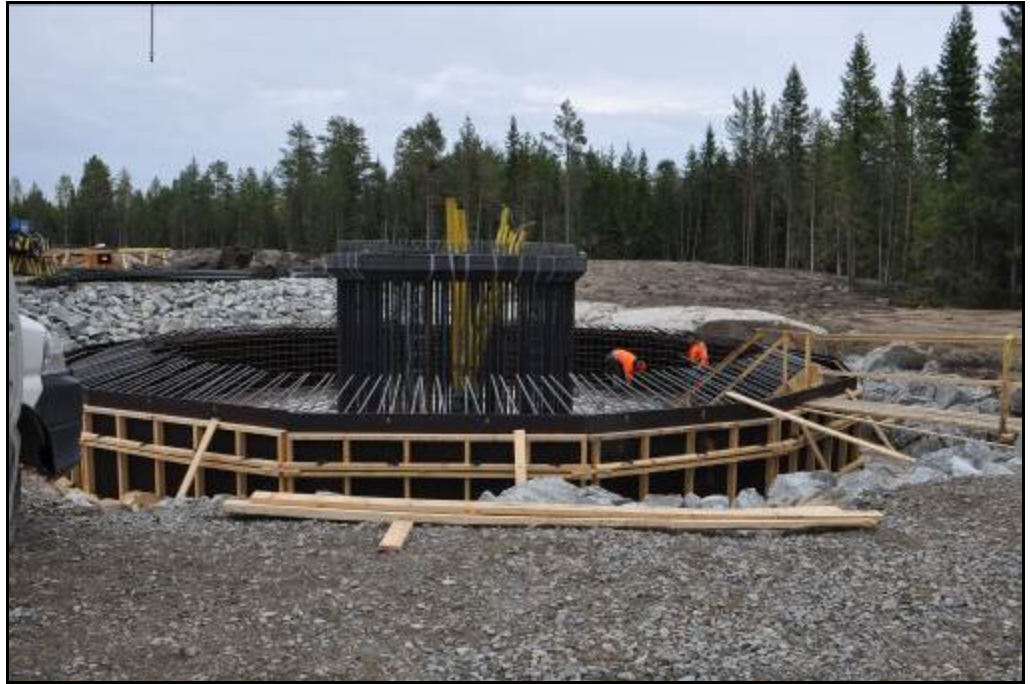
Kuva 4.5. Maavaraisen teräsbetoniperustuksen rakentamisvaihe (Kuva: Leila Väyrynen / FCG).
