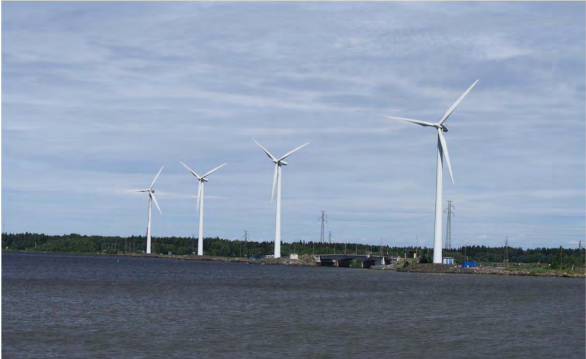
Kuva 17.12. Tuulivoimalan konehuone voi tarjota muuttavalle lepakolle levähdyspaikan etenkin merialueilla.
