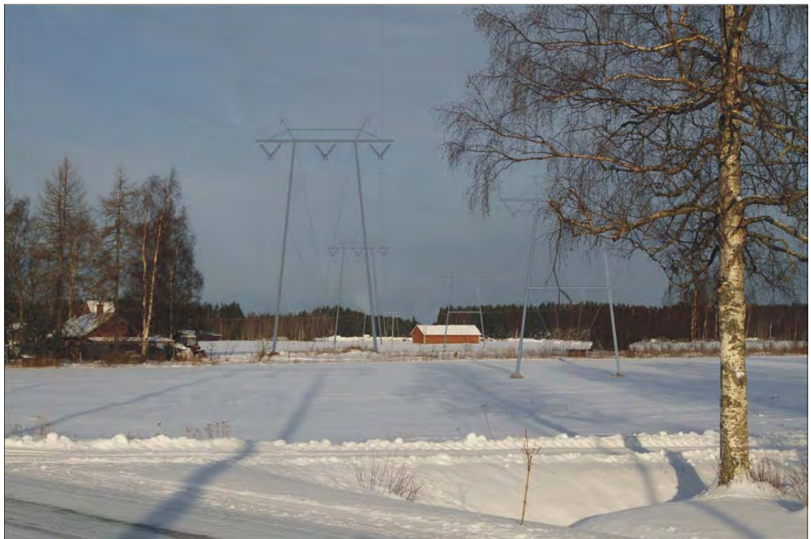
Kuva 12.29. Havainnekuva tulevasta Lappfjärdin ja Lakiakankaan 110 kV voimajohdosta (oikealla) tulevan Fingrid Oyj:n 400 kV voimajohdon (vasemmalla) rinnalla Dagsmarkin kylässä. Kuvassa 110 voimajohto risteää 400 kV voimajohdon kanssa siirtyen sen itäpuolelle.
