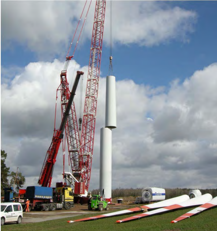
Kuva 3.48. Voimalatornin kokoaminen (Kuva: Erik Trast / CPC Finland Oy)
