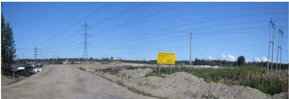
Kuva 3.36. Kristinestadin sähköasemalla tehtiin maanrakennustöitä kesällä 2012.
