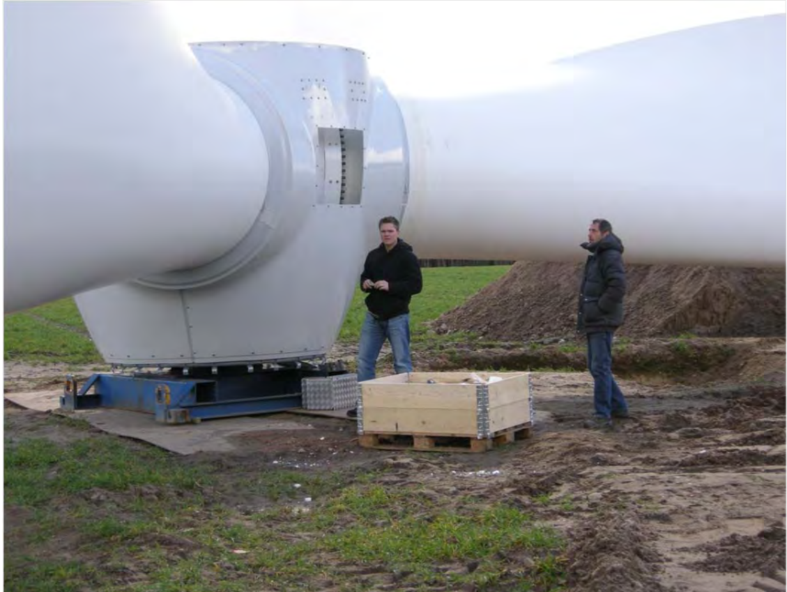
Kuva 3.47. Roottori kootaan maassa (Kuva: Erik Trast / CPC Finland Oy)
