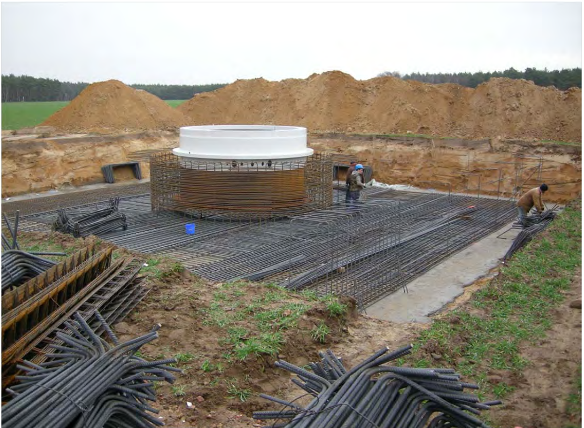
Kuva 3.46. Perustuksen rakentaminen (Kuva: Erik Trast / CPC Finland Oy).
