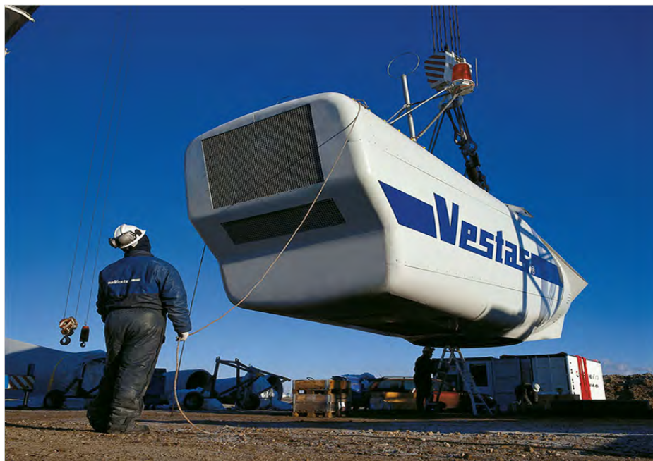
Kuva 3.49. Konehuone nostetaan paikoilleen (Kuva: Erik Trast / CPC Finland Oy).
