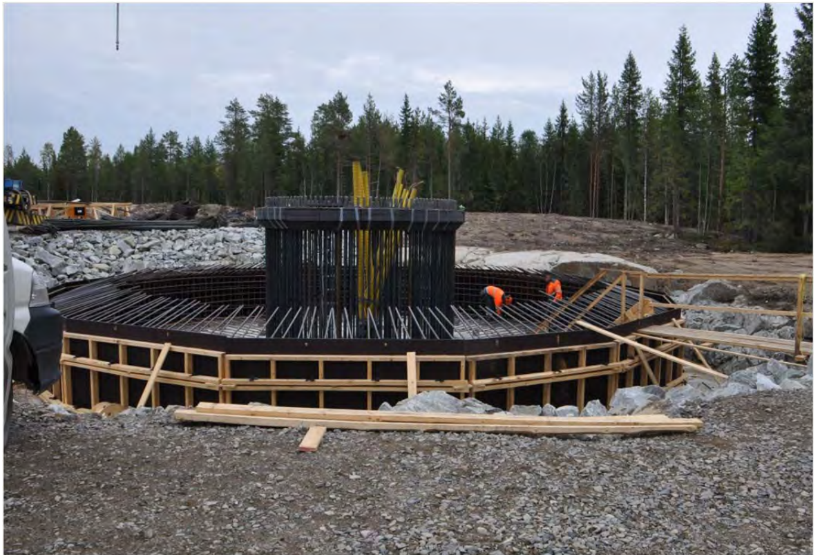
Kuva 3.10. Maavaraisen teräsbetoniperustuksen rakentamisvaihe (Kuva: Leila Väyrynen / FCG).
