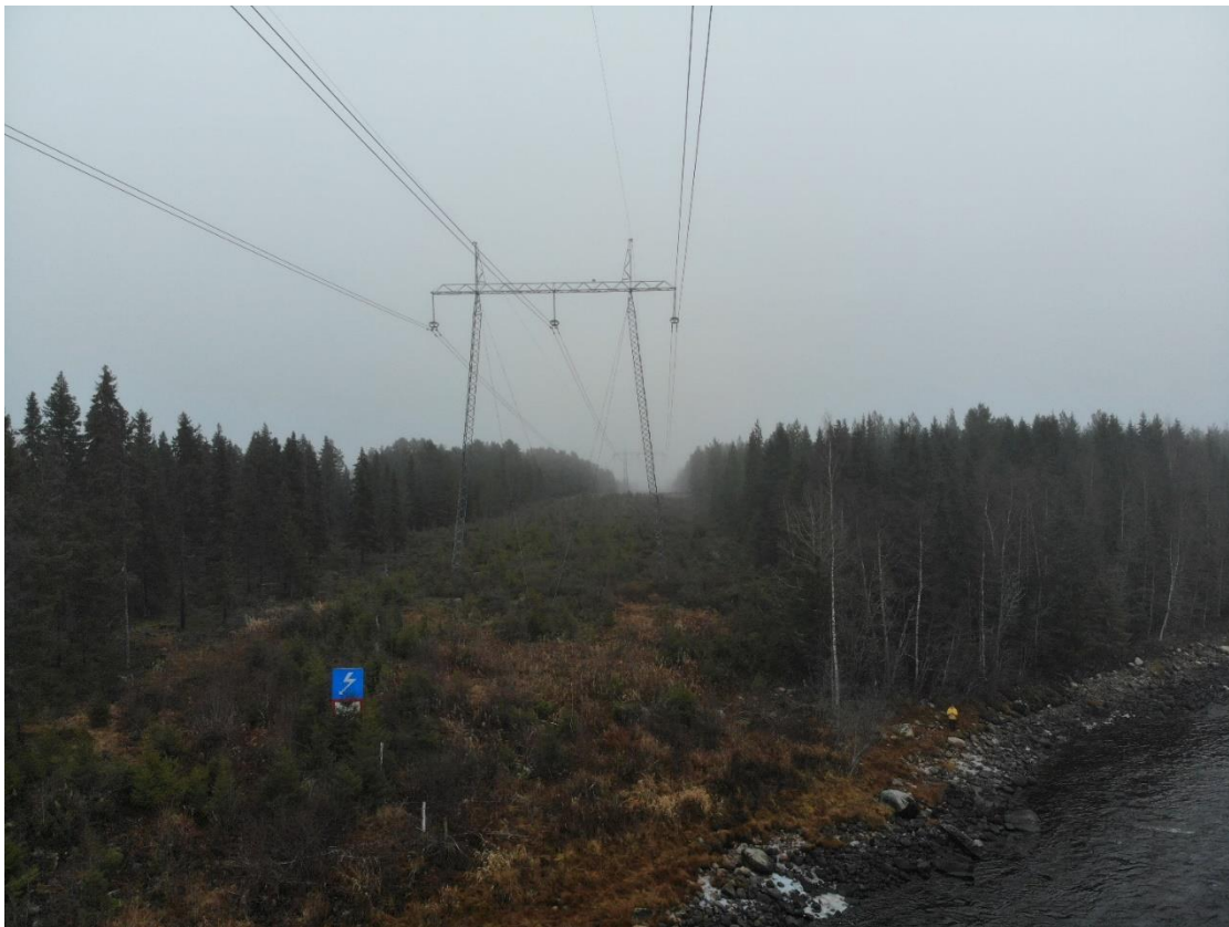
Bild 4. Stagad, tvåfotad portalstolpe. I detta projekt motsvarar stolpkonstruktionen den stolptyp som finns på bilden. Bild: Nuvarande 400 kilovolts kraftledning vid Torne älv.
