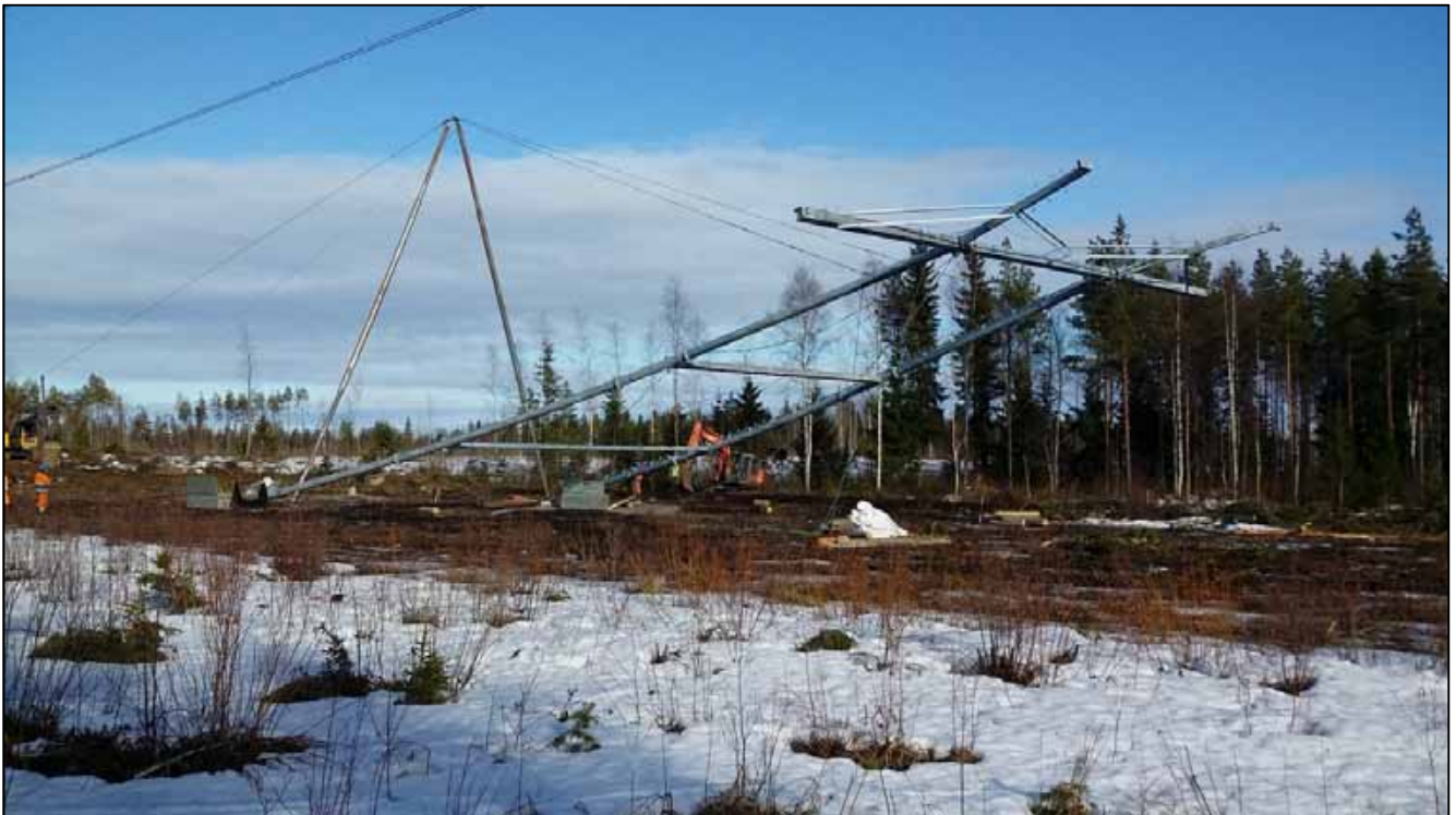
Kuva 10. Voimajohtopylvään pystytys.
