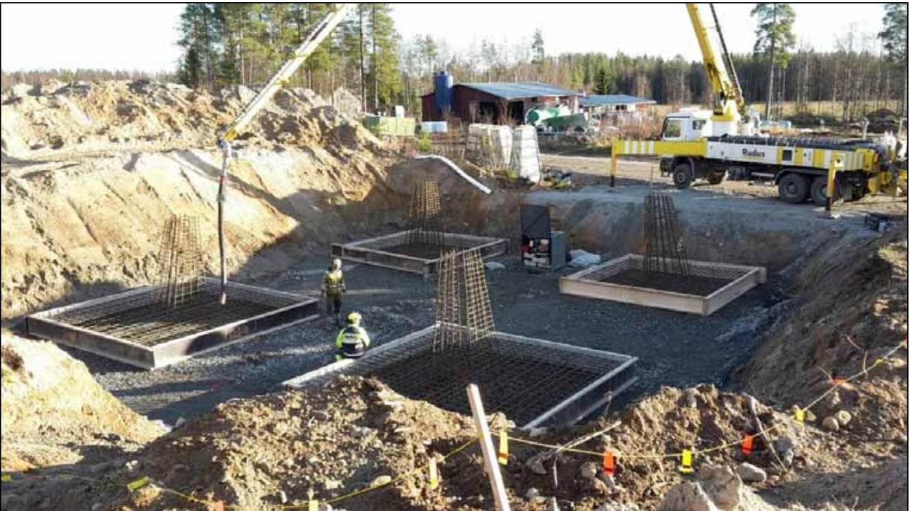
Kuva 9. Vapaasti seisovan pylvään perustuksen pohjatöitä.
