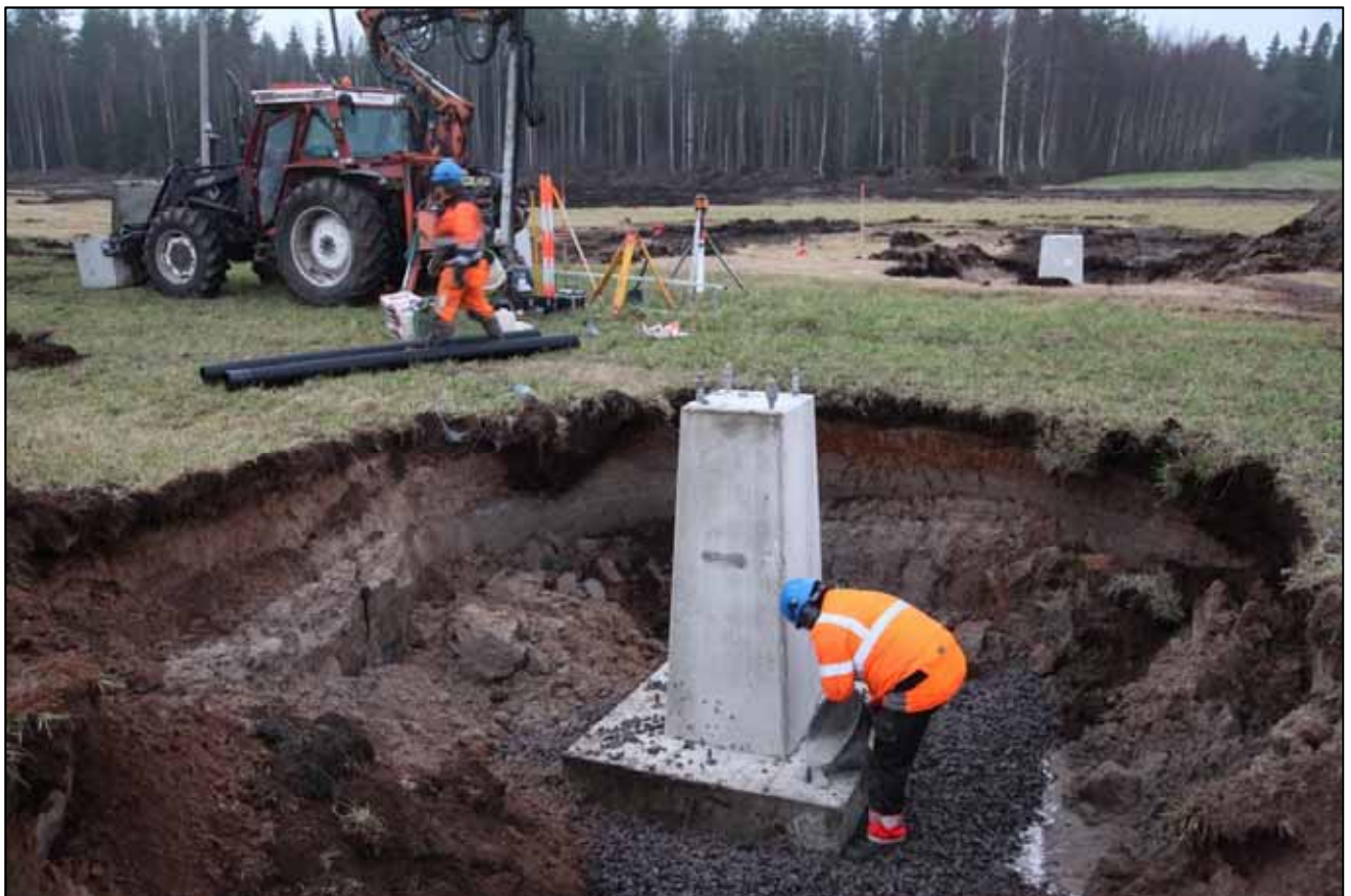
Kuva 9. Pylvään perustuselementin asentaminen.
