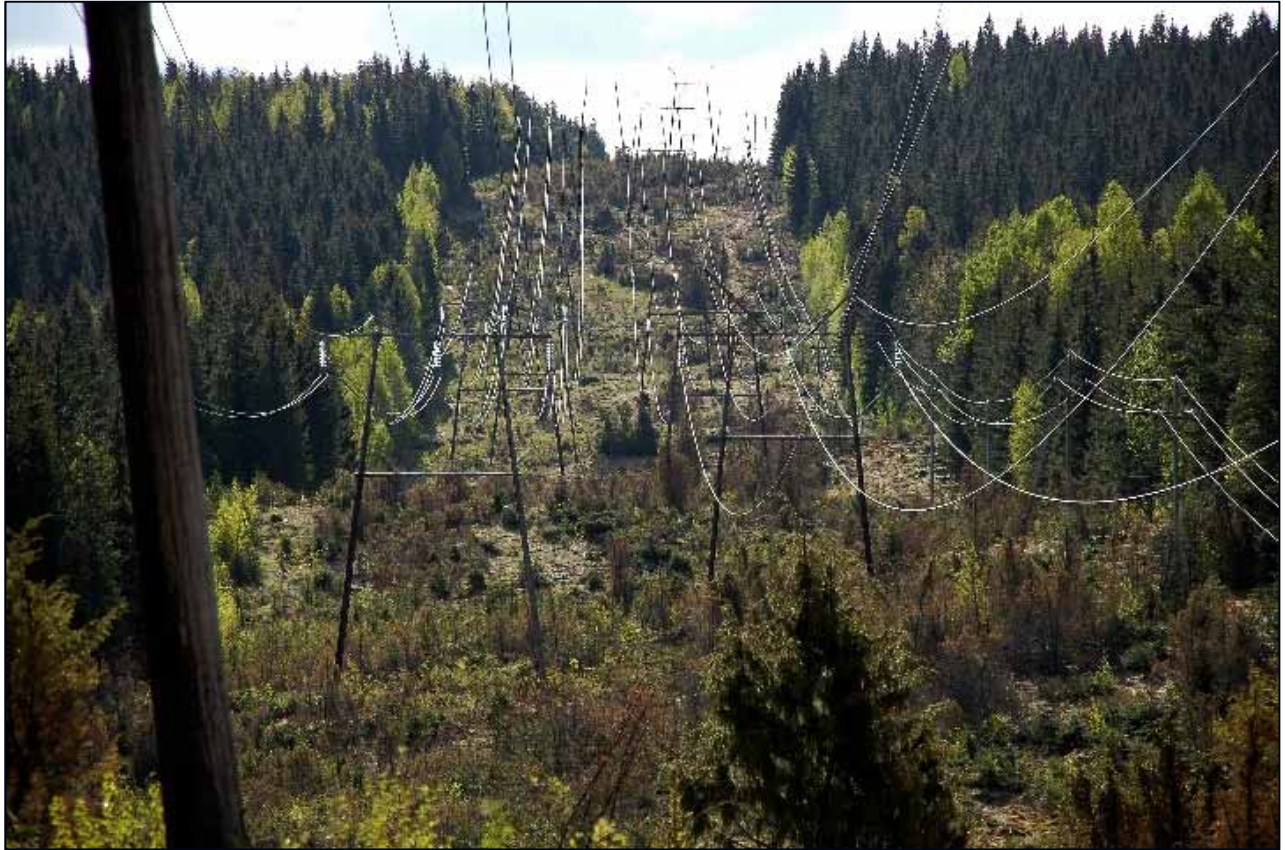
Kuva 12. Esimerkki valikoivasta raivauksesta.
