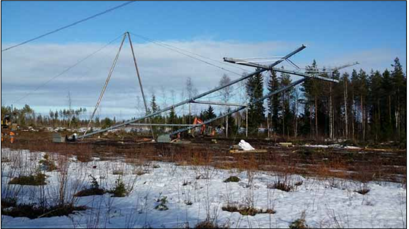
Kuva 11. Voimajohtopylvään pystytys.
