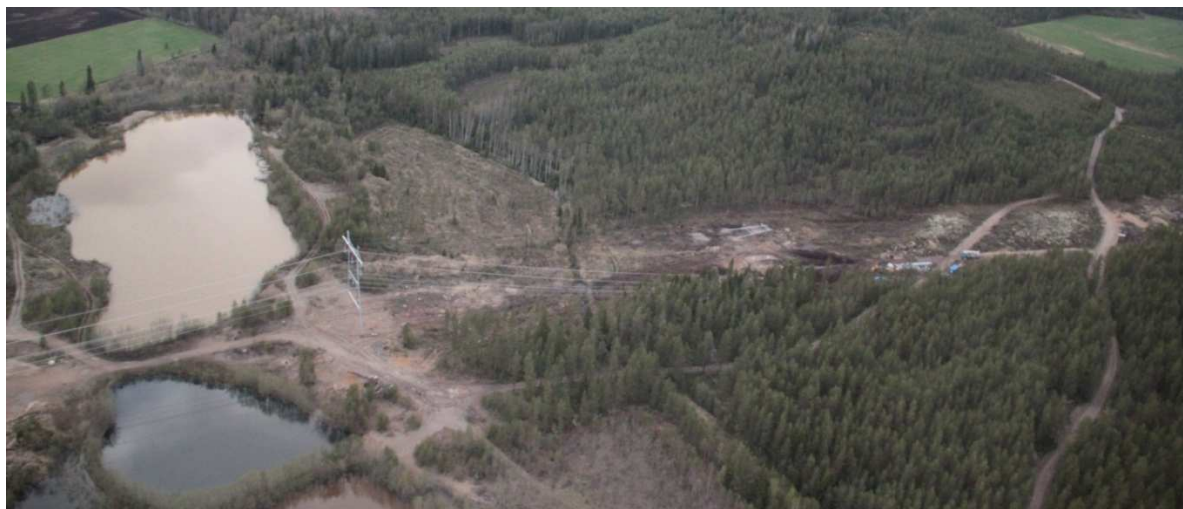
Kuva 137. Ilmakuva voimalinjarakennustyömaalta Kokkokankaan hankealueen eteläpuolelta.
