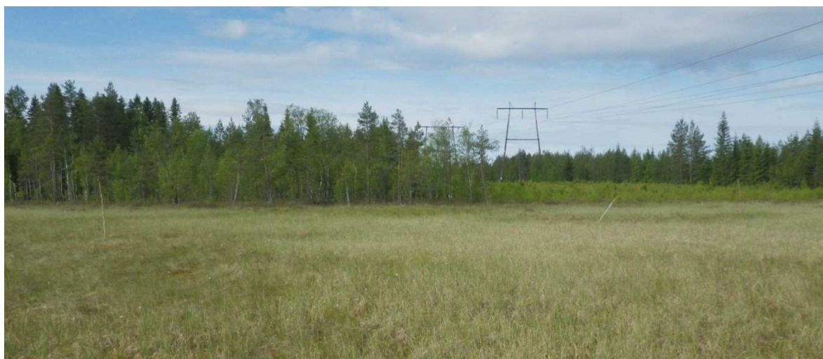
Kuva 139. Kokkokankaan hankkeen voimalinja sijoittuu Ruhalampin suoalueella kuvassa olevien voimalinjojen oikealle puolelle, suon jo rakentuneeseen pätyyn.
